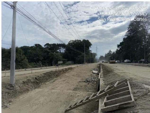
Construcción de tragante en rampa 3, entrada de túnel.
