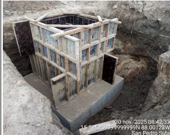
Encofrado para fundir base para sistema de iluminación.
