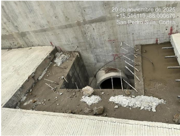
Construcción de tragante en rampa 3, entrada de túnel.
