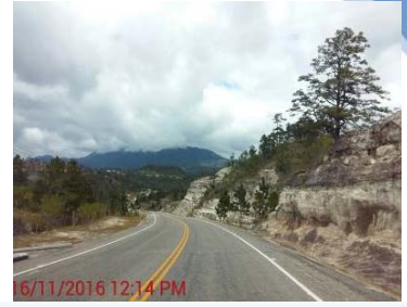
Las cunetas se encuentran limpias, libres de sedimentos
