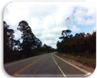
Vista de bordillos en causadores de aguas lluvias
