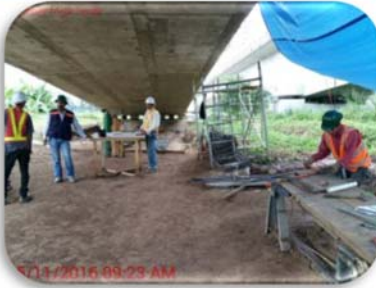
Vista del taller de trabajo bajo el puente
