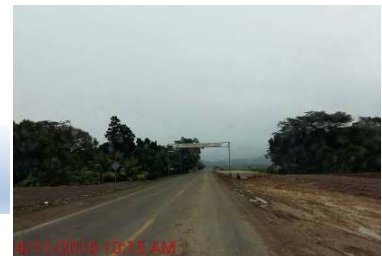
Terracerías de ampliación a ambos lados
