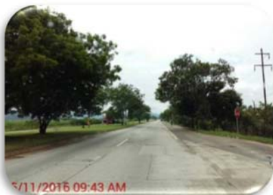
Vista General del Tramo
