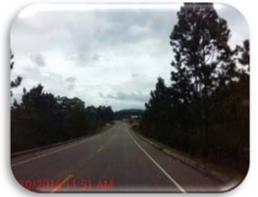
No se encuentran baches en la calzada
