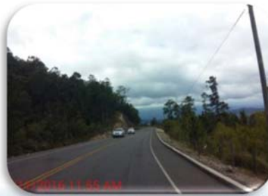
Vista de la calzada y bordillos de control de aguas sobre la calzada
