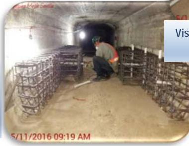
Otra vista al interior del puente, donde se construyen los bloques de anclaje para cierre de fisuras entre dovelas, del Puente La Democracia
