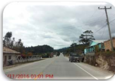
La superficie de la calzada luce con muy buen acabado.
