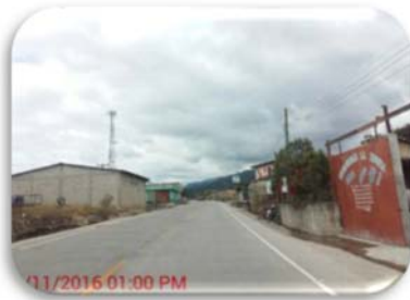
Vista general del tramo al inicio, municipio de San Juan
