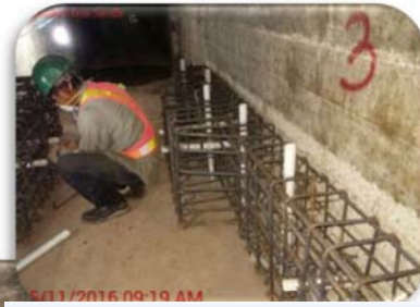
Vista cercana de los trabajos al interior del puente
