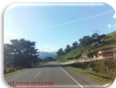
Vista del tramo en el Km 90
