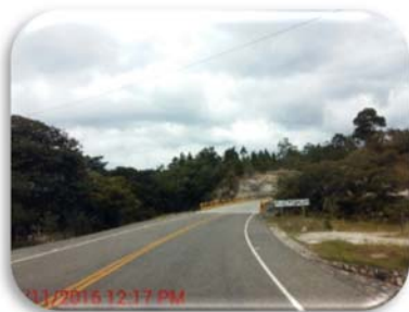
Aproximación al puente Río Chiquito, se encuentra en buen estado
