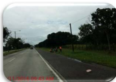
Cuadrillas de mantenimiento en limpieza del derecho de vía.
