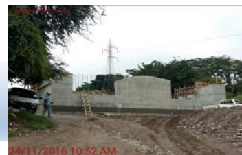
Vista del estribo No 2 ya terminado
