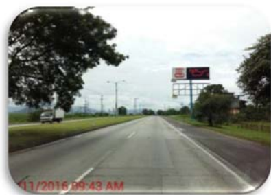
Vista de Estación de Peaje San Manuel
