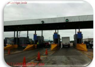
Vista general del tramo, mediana limpias
