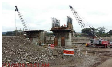
Vista de la Pila No 2 del Puente Santa Rita, ya terminada a nivel de primera dovola
