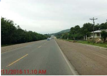
Vista de un tramo de ampliación de carriles
