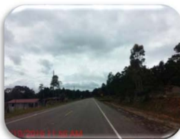
Las cunetas se mantienen limpias
