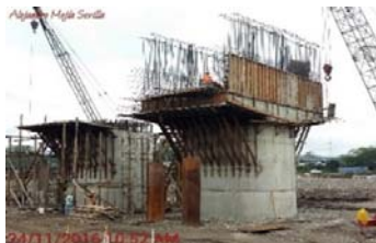
Otra vista más cercana de la misma pila, se trabaja en la preparación de fundición de la primera dovola
