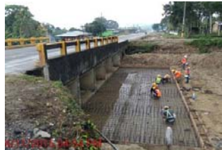
Ampliación de caja de puente,
