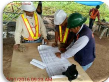
Ingenieros del Subcontratista MEXPRESA, en labores de planificación de trabajos
