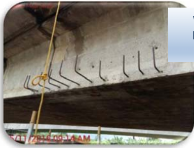
Otra vista al interior del puente, donde se construyen los bloques de anclaje para cierre de fisuras entre dovelas, del Puente La Democracia
