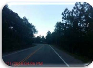
La señalización horizontal se encuentra en buen estado
