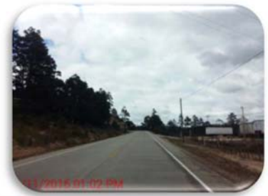
La señalización horizontal es de buena calidad
