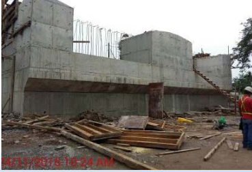
Vista del estribo No 1 terminado
