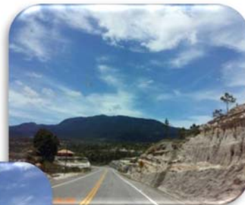
No se encuentran derrumbes en los taludes vulnerables por suelos frágiles
