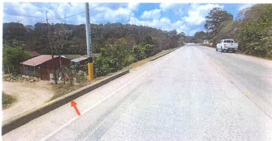
Toma del Bordillo de Carretera en el Km 51+245 L. I., se puede ver que se mantiene en buen estado y libre de materiales en su costado.
