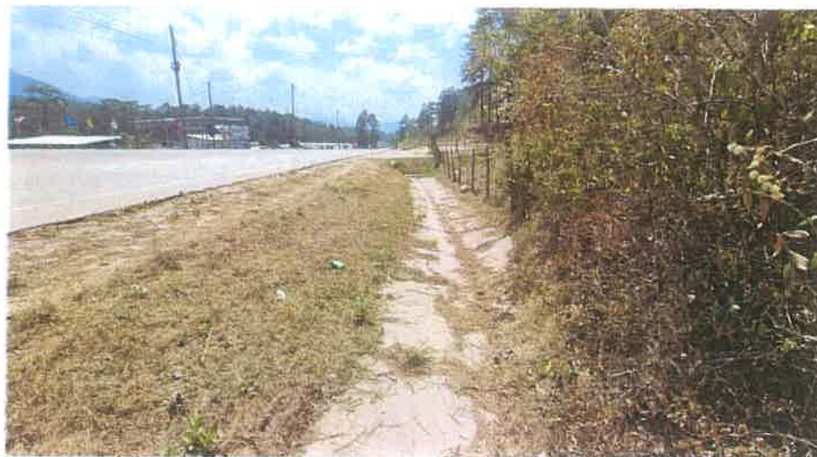
Toma de la Cuneta Enchapada del Km 49+730 L. I., se puede ver que se encuentra totalmente limpia, sin basura y sin sedimentos.
