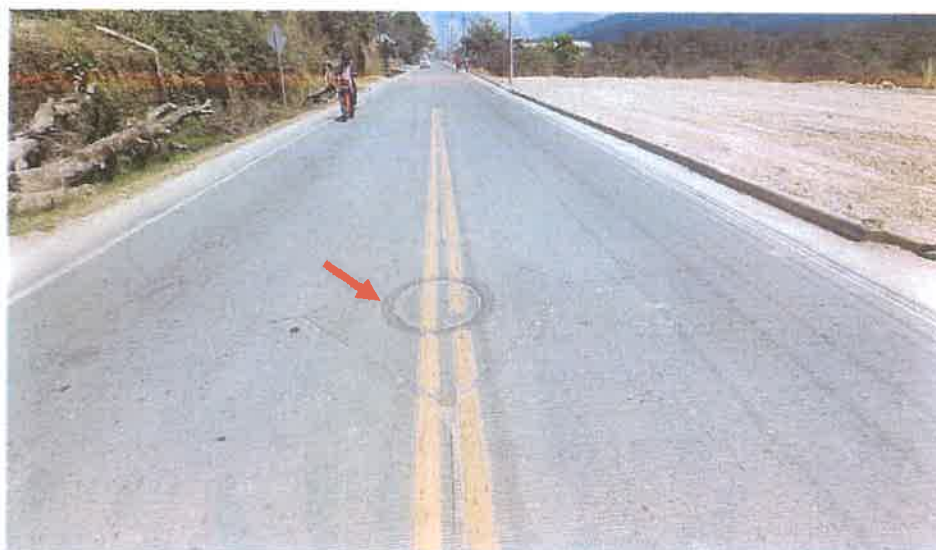
Pozo de Inspección construido en el Km 48+267 donde se puede observar que aun se mantiene en buen estado y sin problemas.
