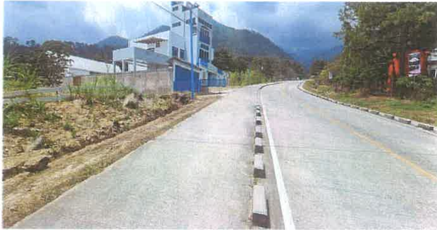
Toma del tramo de Ciclovía en el Km 4+822. Se puede constatar que la Ciclovía se mantienen en buen estado.
