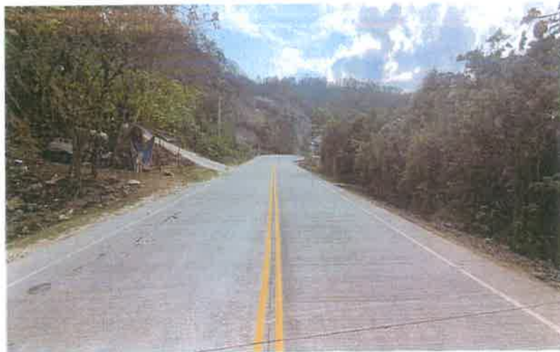
Toma de la Calzada de Rodadura del Km 78+742 donde se puede observar que esta se mantiene limpia y sin baches.
