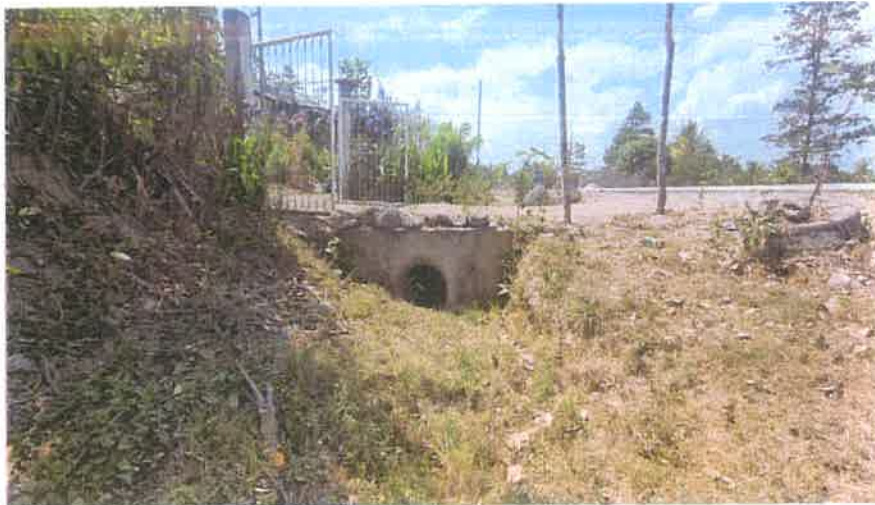
Toma en el Acceso Lateral del km 65+100 L. I., se puede observar que tanto su salida y su interior están limpios.
