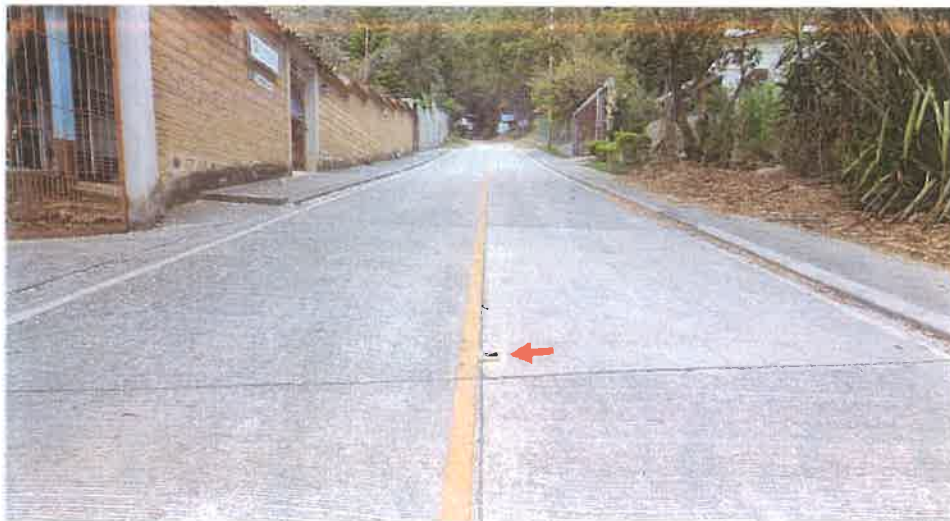
Toma en la Hombro Derecho del Km 5+437, donde se puede constatar que tanto la Pintura Termoplastica como las Vialitas de ese tramo se mantienen buen estado.
