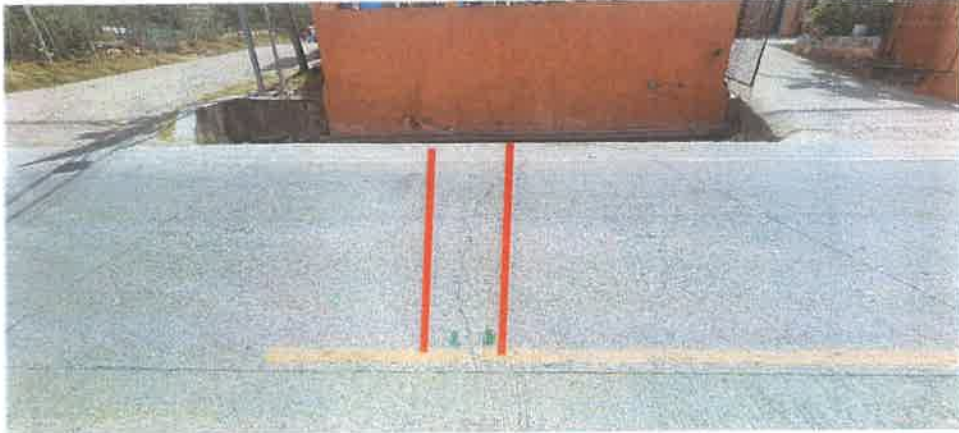
Sellar Grieta en el Km 57+032 L. D.
