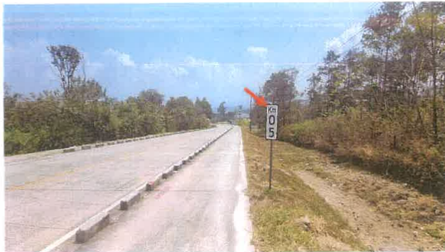
Toma de la Señal Vertical instalada en el Km 5+000 L. I., se puede ver que se mantiene en buen estado y limpia.
