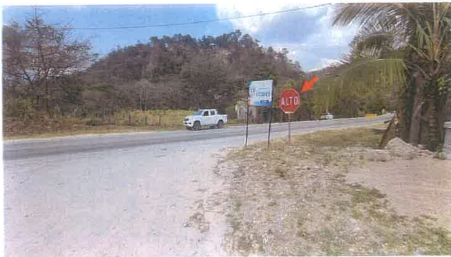
Toma de la Señal Vertical del km 81+181 L. I. donde se puede observar que se mantiene en buen estado.
