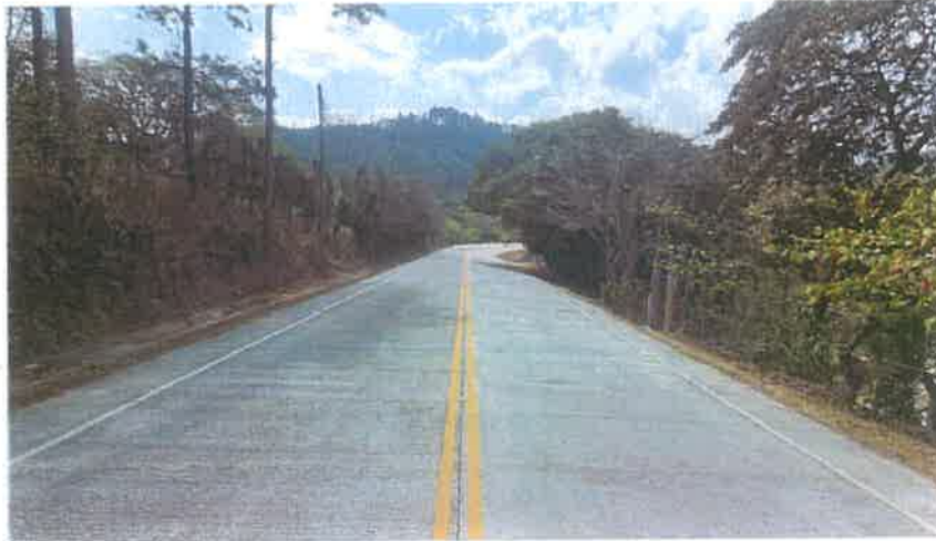
Toma de la Calzada de Rodadura en el Km 67+123 donde se puede observar que la calzada se mantiene totalmente limpia y sin baches.
