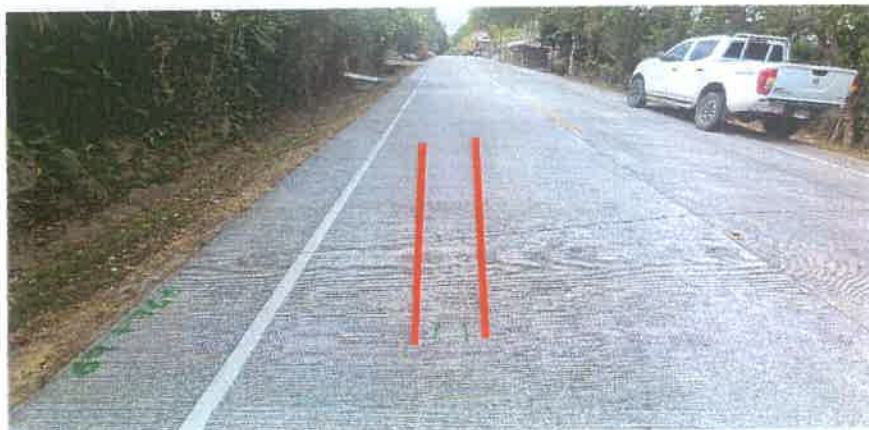
Sellar Grieta en el Km 69+782 L. I.
