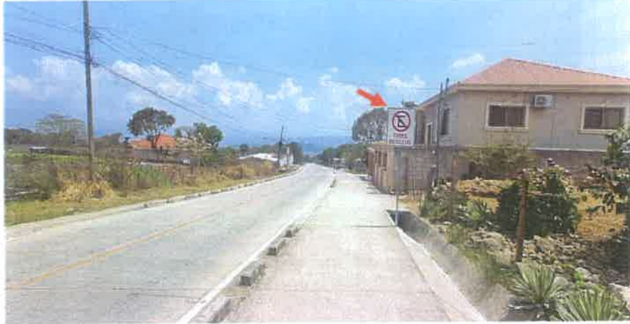
Toma de la Señal Vertical del Km 3+127 L. I., donde se puede ver que la señal instalada aun se mantiene en buen estado y a plomo.
