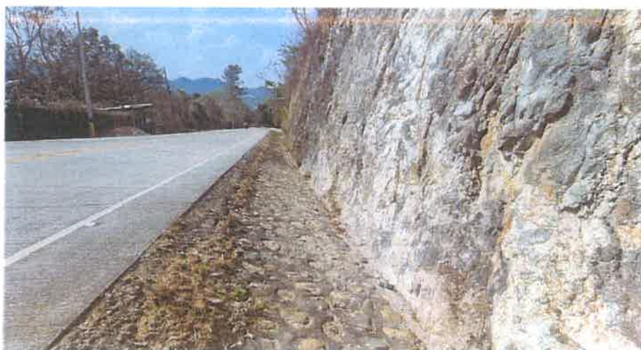
Toma de la Cuneta Enchapada en el Km 75+169 L. D., donde se puede observar que esta totalmente limpia y sin material azolvado.
