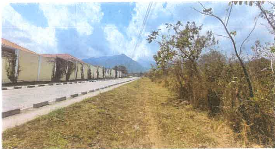
Toma en el Derecho de Via en el Km 3+192 L. D., observese que está completamente limpio y la maleza a niveles de Especificaciones
