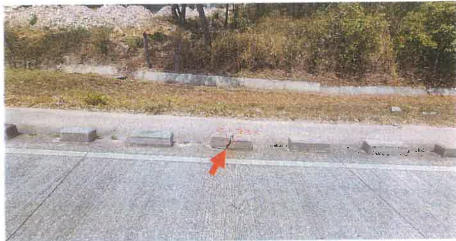
Reconstruir Bloque de Bordillo Intermitente en el Km 2+957 L. D.
