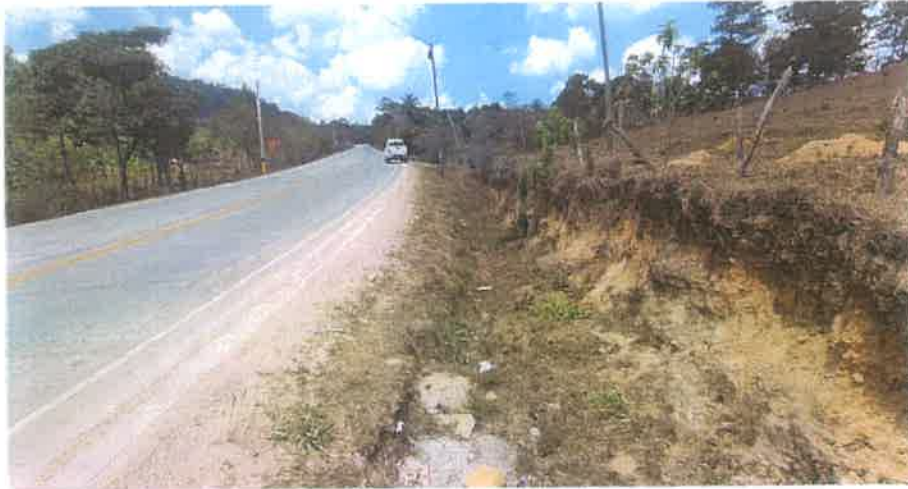
Cuneta sin Enchape del Km 51+132 L. D. Se puede observar que el agua lluvia podría fluir por sobre la cuneta y no se observan erosiones que afecten la carretera.
