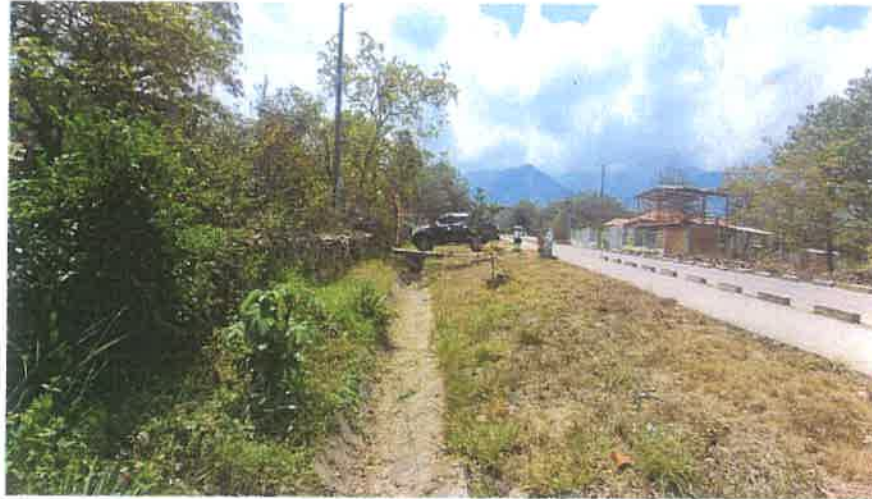
Imagen de la Cuneta Enchapada del Km 2+276 L. I. donde se puede observar que se mantiene limpia.
