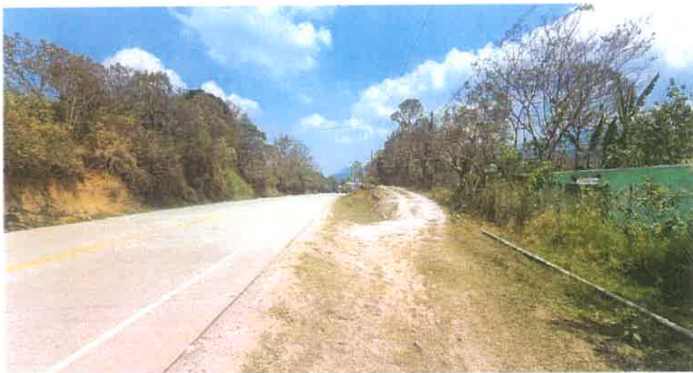
Imagen en el Derecho de Via en el Km 54+090 L. D. Observese que se mantiene totalmente limpio y la maleza dentro de Especificaciones.
