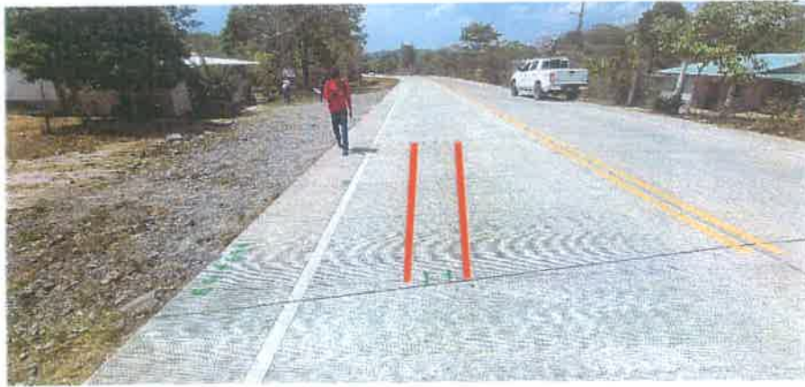
Sellar Grieta en el Km 64+973 L. I.
