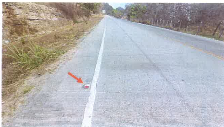
Toma en la pintura del Hombro Derecho y la Violeta del km 81+525 donde se puede observar que aun están en buen estado y se mantienen colocadas.
