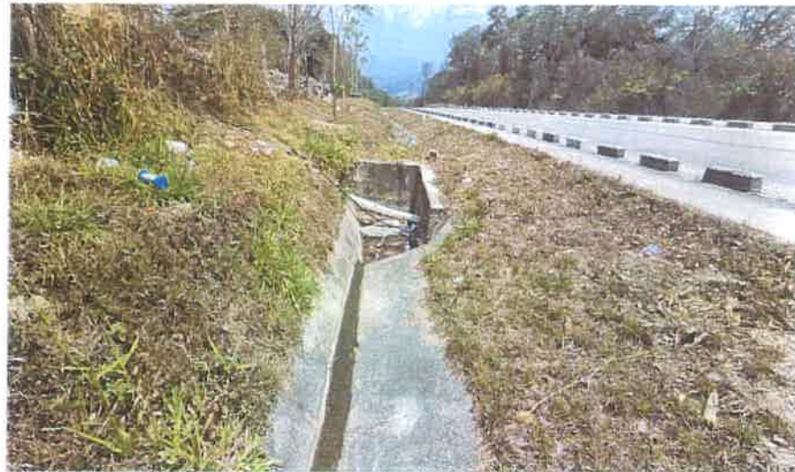
Toma en la entrada de la Alcantarilla Transversal en el Km 1+715. Observese que esta libre de materiales.
