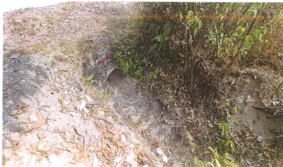
Toma en la salida de la Alcantarilla Transversal del Km 74+180, se puede observar que su canal de salida en condiciones de drenaje aceptables.
