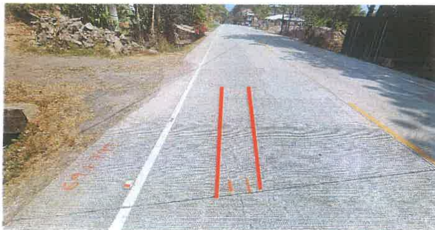
Sellar Grieta en el Km 72+332 L. D.
