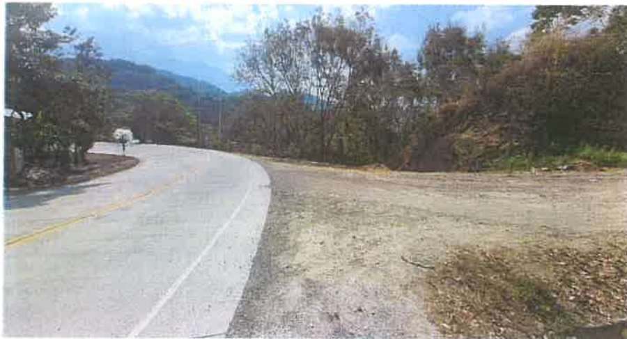
Acceso Lateral con pavimento en el Km 75+940 L. D., se puede ver que se mantiene en buen estado y sin hacer grada en el hombro.
