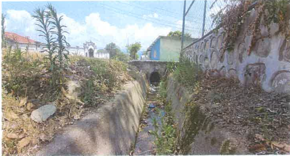
Toma del Acceso Lateral del Km 3+042 L. I. Observe que tanto su salida e interior están totalmente limpios.
