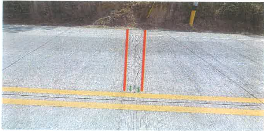
Sellar Grieta en el Km 67+162 L. I.
