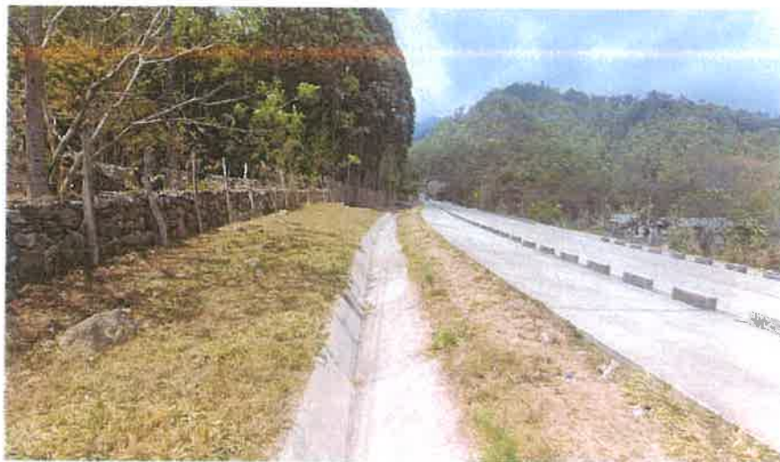
Toma de la Cuneta Enchapada del Km 5+172 L. I. Se puede observar que se mantiene totalmente limpia y libre de sedimentos.
