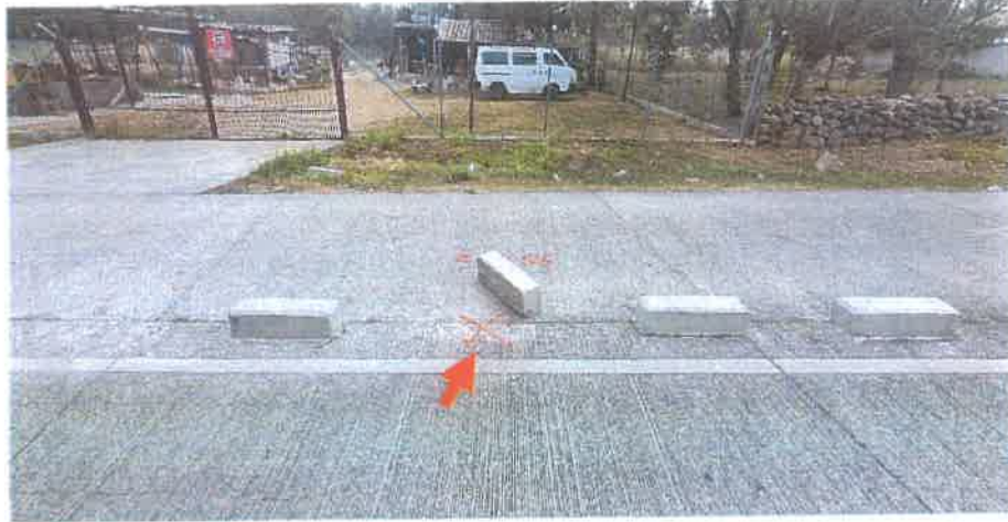
Reconstruir Bloque de Bordillo Intermitente en el Km 2+735 L. D.
