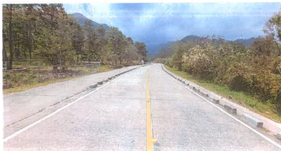
Toma de la Calzada de Rodadura del Km 4+918, se puede ver que esta totalmente limpia y sin baches.
