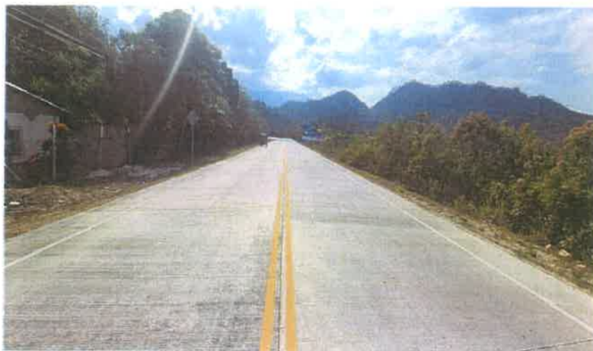
Toma de la Pintura Termoplastica colocada en el Km 78+518 en línea central, donde se puede observar que en este tramo aun está en buen estado.
