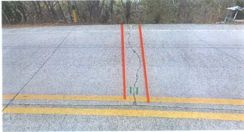
Sellar Grieta en el Km 67+118 L. D.
