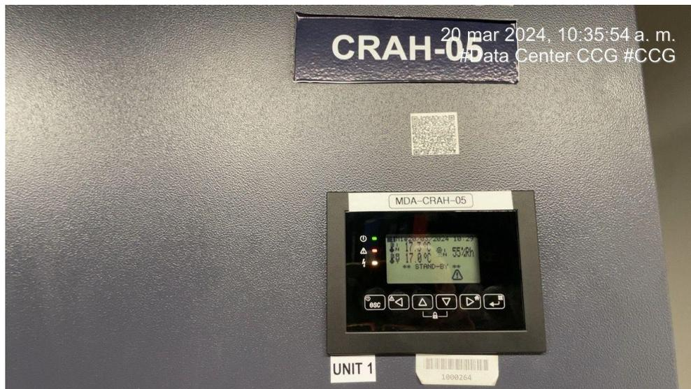
Imagen 7. Aire de precisión redundante
