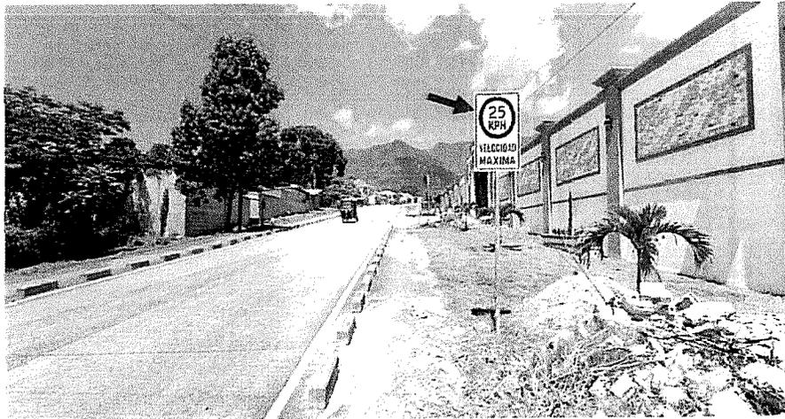
Toma de la Señal Vertical del Km 2+985 L. D., donde se puede ver que la señal instalada aun se mantiene en buen estado y a plomo.
