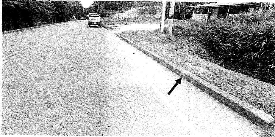
**Toma del Bordillo de Carretera en el Km 51+971 L. I., se puede ver que se mantiene en buen estado y libre de materiales en su costado.**
