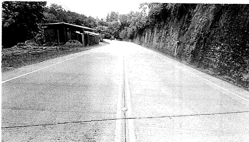
Toma de la Pintura Termoplástica colocada en el Km 70+297 en línea central, donde se puede observar que en este tramo aun está en buen estado.
