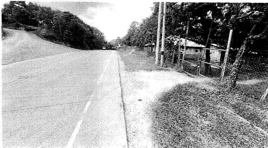
**Toma del Acceso lateral sin Pavimento del km 54+073 L. D., observese que aún se mantiene sin producirse grada entre la losa y la cuña de B-C.**
