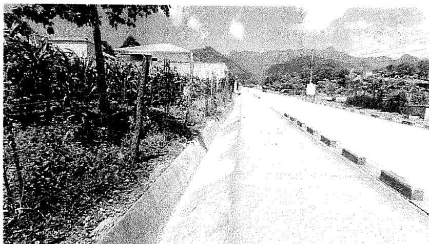
**Toma de la Cuneta Enchapada del Km 3+145 L. I. Se puede observar que se mantiene totalmente limpia y libre de sedimentos.**
