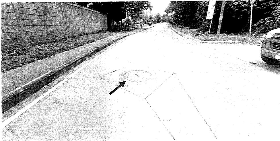
**Toma de la Tapadera en el Pozo de Inspección en el Km 1+170. Se puede ver que esta en buen estado.**
