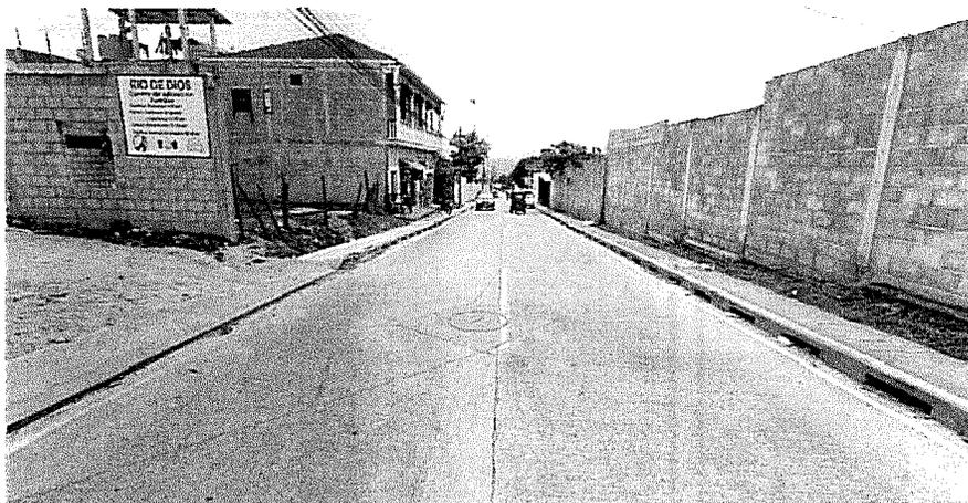
Toma de la Calzada de Rodadura del Km 0+345 donde se puede constatar que esta totalmente limpia y sin baches.
