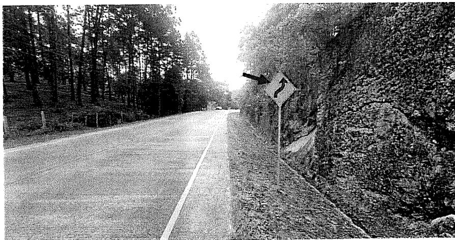
Toma de la Señal Vertical instalada en el Km 50+095 L. D., observese que aun se mantiene en buen estado y a plomo.
