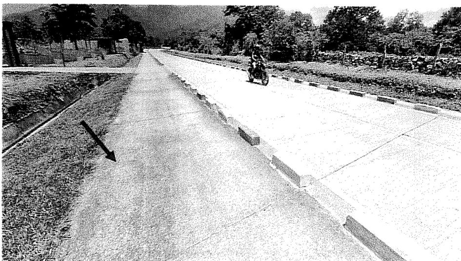
**Toma de la Acera (rojo) y Bordillo Intermitente (Amarillo) en el Km 1+794 L. I., observese que ambos se mantienen en buen estado.**
