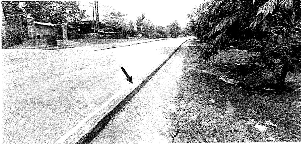
**Toma de la Acera y Bordillo Continuo en el Km 1+242 L. D. Se puede observar que se mantienen en buen estado, limpia y completos.**
