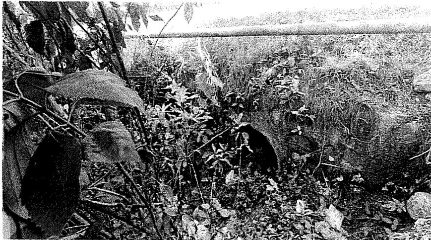
Toma de la Alcantarilla Transversal del Km 52+537 donde se puede observar su salida completamente limpia.
