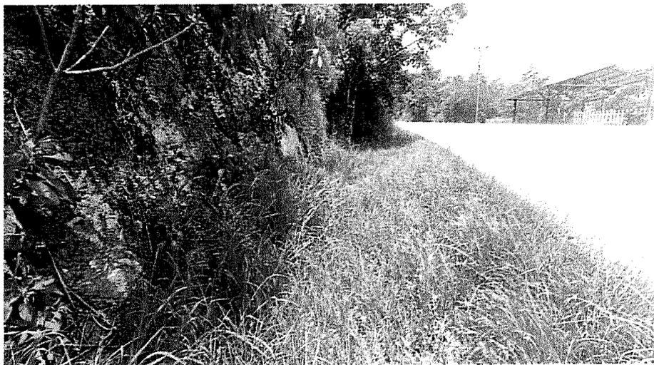
Toma de la Cuneta sin Enchape del Km 80+601 L. I. observese que se mantiene sin erosiones que pongan en riesgo la calzada.
