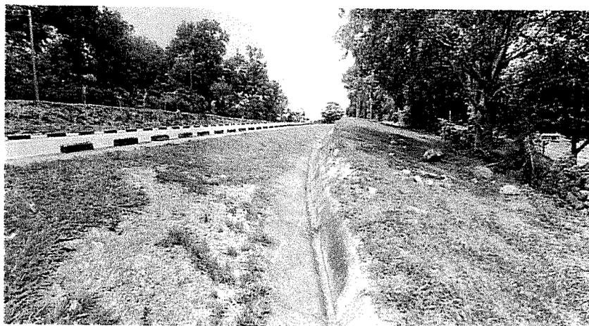
**Imagen de la Cuneta Enchapada del Km 1+620 L. D. donde se puede observar que se mantiene limpia.**
