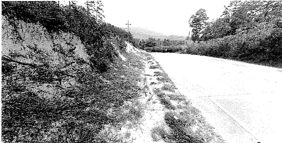
Cuneta sin Enchape del Km 61+047 L. I. Se puede observar que el agua lluvia podría fluir por sobre la cuneta y no se observan erosiones que afecten la carretera.
