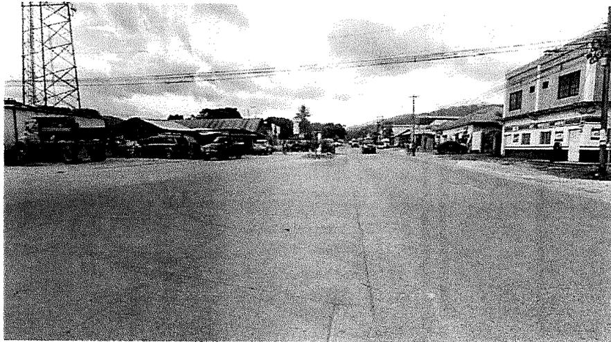
**Acceso Lateral con pavimento en el Km 48+760 L. I., se puede ver que se mantiene en buen estado y sin hacer grada en el hombro.**
