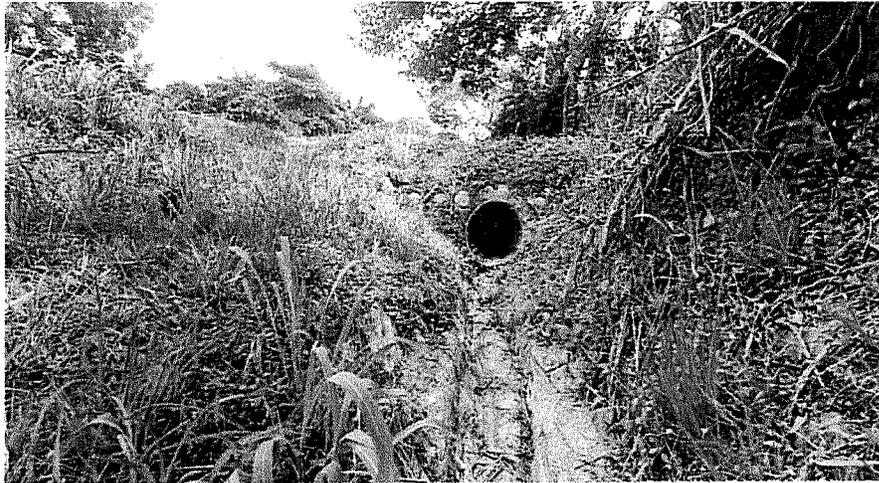
Imagen en el Acceso Lateral en el Km 64+473 L. I. donde se puede observar la tubería que esta limpia tanto en su salida como su interior.
