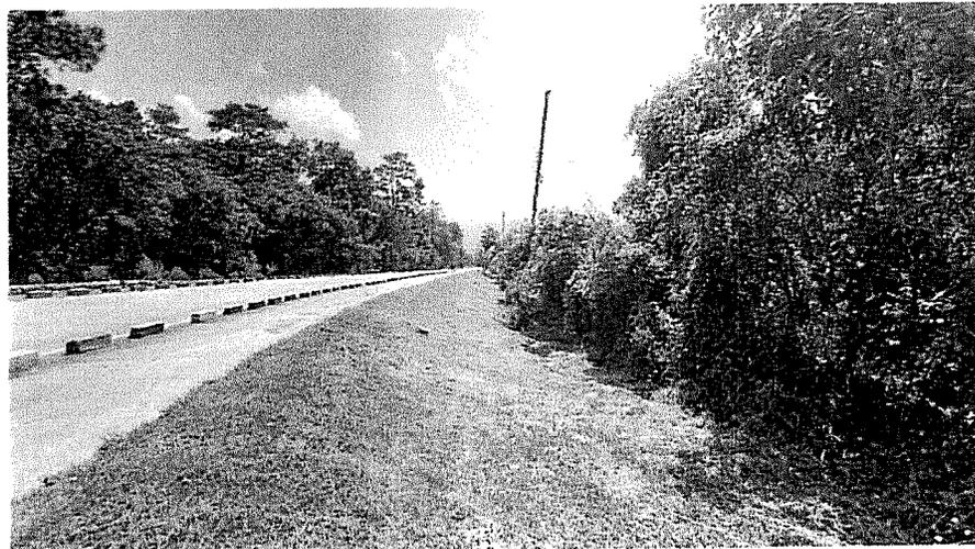
**Toma de la Cuneta sin Enchape del Km 4+209 L. I. Se puede observar que esta limpia y sin erosiones.**
