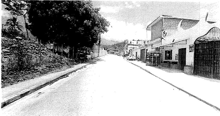
Imagen de la Pintura Termoplástica del Km 0+951 donde se puede observar que la de la línea central aun se mantiene en buen estado.
