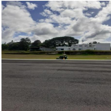
Mantenimiento de las zonas verdes, franja de seguridad de la pista. Se observa la ejecución de actividades de corte y limpieza de vegetación en la franja de seguridad de la pista, con el objetivo de mantener niveles adecuados de visibilidad y minimizar riesgos de presencia de FOD.
