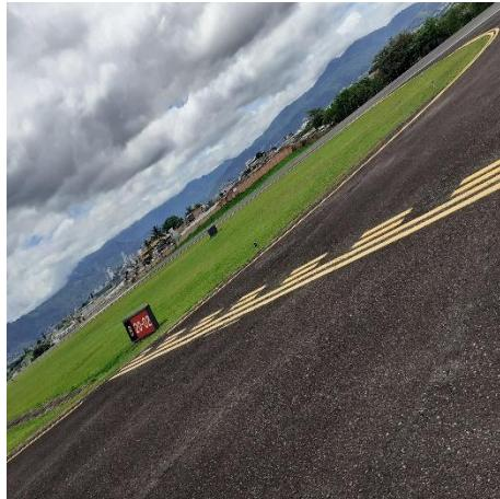
Inspección de ayudas visuales (letreros). Revisión del estado físico y funcional de los letreros de ayudas visuales, verificando iluminación, orientación y condiciones de reflectividad para garantizar la correcta guía a pilotos.
