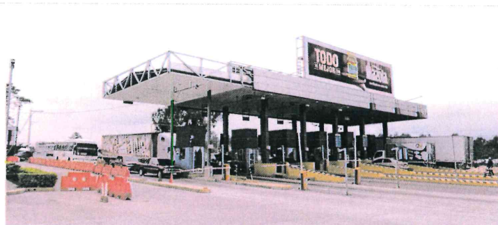
Funcionamiento casetas en peaje de Siguetepeque, km. 112+500
