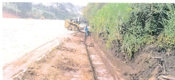
Limpieza de cunetas azolvadas por material suelto Km. 167+000
