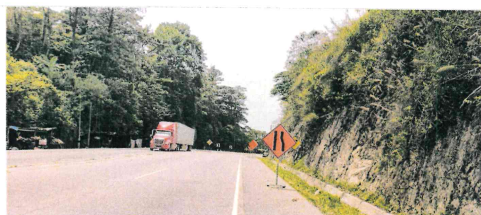
Falta de ampliación paso del lago de Yojoa, km. 154+000-155+000
