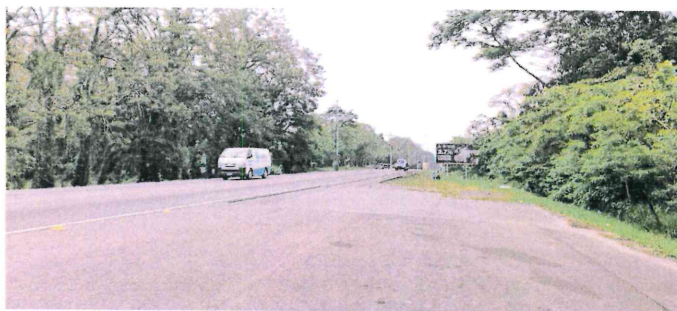
Falta de ampliación 158+200-158+400 y 159+500-162+300
