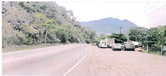
Falta de ampliación 158+200-158+400 y 159+500-162+300
