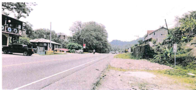
Falta de ampliación 158+200-158+400 y 159+500-162+300
