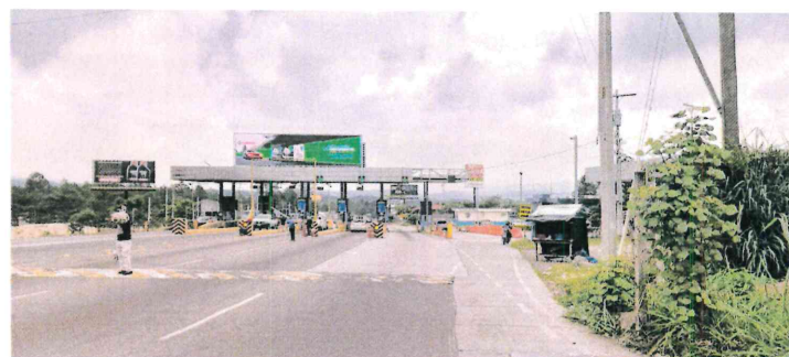
Funcionamiento de casetas en peaje de Siguatepeque, km. 112+500
