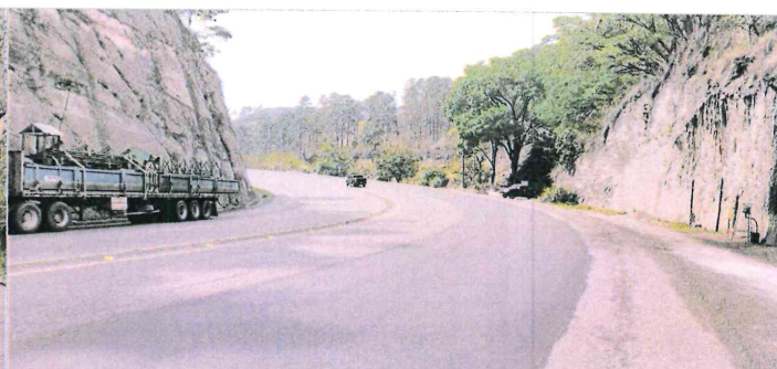
Falta de ampliación 158+200-158+400 y 159+500-162+300
