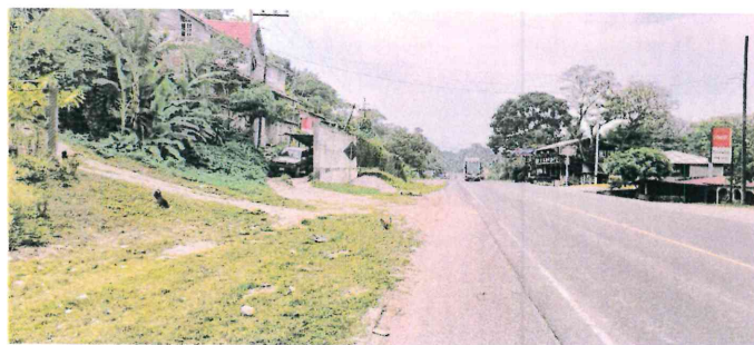
Falta de ampliación 158+200-158+400 y 159+500-162+300
