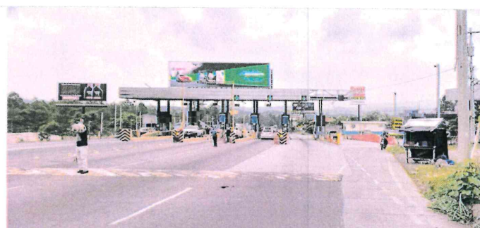
Funcionamiento casetas en peaje de Siguetepeque, km. 112+500
