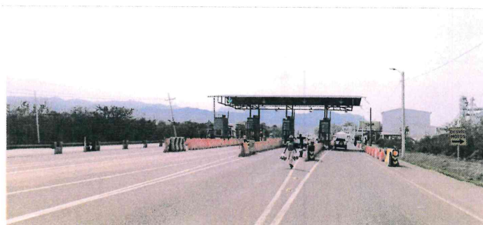
Funcionamiento de casetas en peaje de Siguatepeque, km. 112+500
