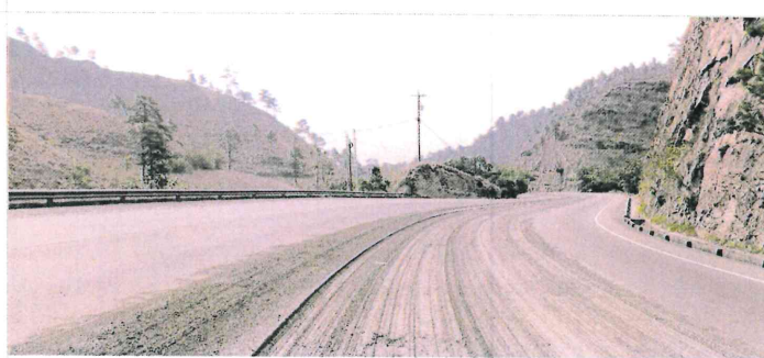
Colocando nueva Carpeta asfáltica en tramos dañados km- 88+000-112+000
