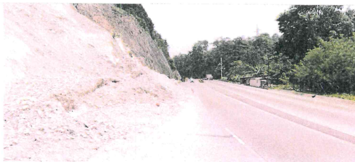
Aun no se retira derrumbe en sector de Carrizal Km. 131+300
