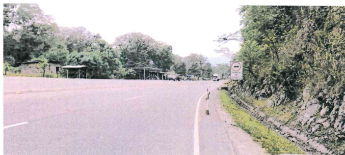
Falta de ampliación 156+700-166+000
