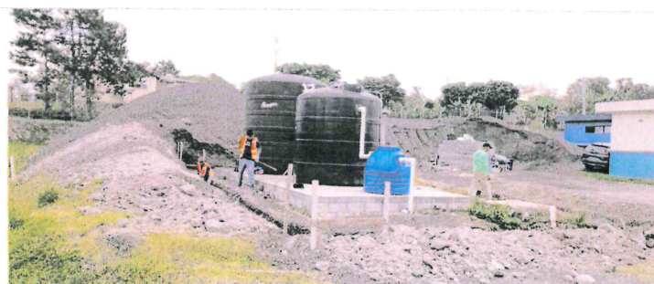
Se construye muro perimetral para tanque de almacenamiento de agua (peaje Siguetepeque), km. 112+500
