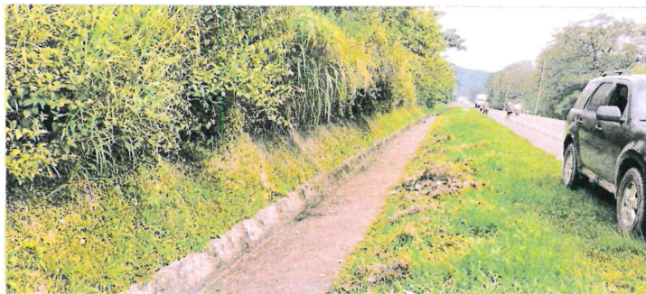
Mantenimiento en hombros Km. 144+000
