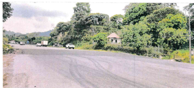
Falta de ampliación 158+200-158+400 y 159+500-162+300
