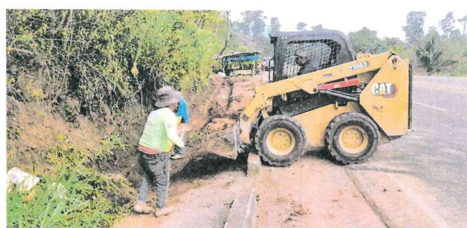
Limpieza de cunetas azolvadas por material suelto Km. 167+000
