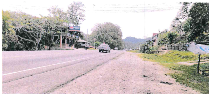
Falta de ampliación 158+200-158+400 y 159+500-162+300
