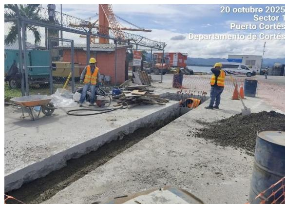
Se observa personal de la empresa constructora ETERNA instalando cableado de fibra, esta actividad se realiza cerca de las instalaciones del muelle 5 costado Este.
