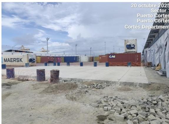
Se observan área de losas de concreto hidráulico fundidas en área de revisión de contenedores en Centro Logístico.
