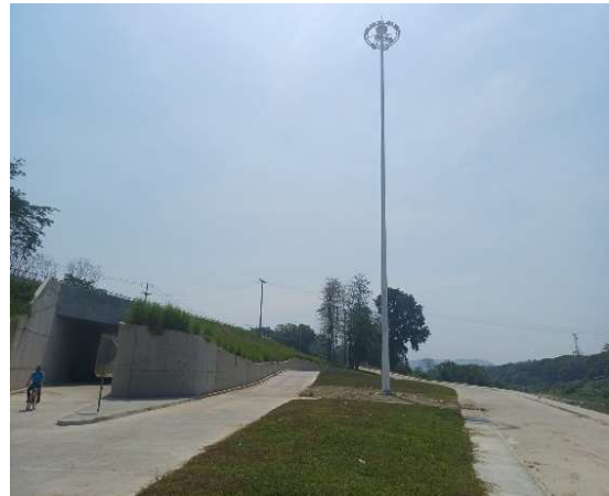
Vista de torre de iluminación de lado Este del proyecto.
