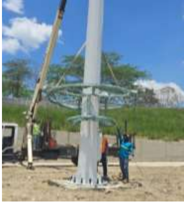
Instalación de primer tramo de torre de iluminación de lado Este del proyecto.
