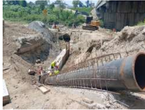
Armado de acero de viga de protección para tubería de hierro negro de 24".
