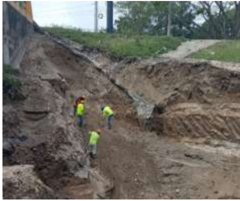
Conformación del terreno para la nueva línea de tubería.
