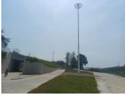
Vista de torre de iluminación de lado Este del proyecto.
