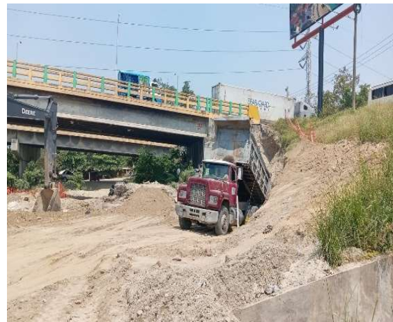
Relleno y compactación sobre viga de protección de nueva línea de tubería de hierro negro de 24”.
