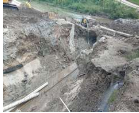
Armado de acero de viga de protección para tubería.
