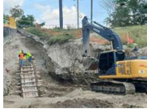
Colado de concreto de viga de protección para tubería de hierro negro de 24".
