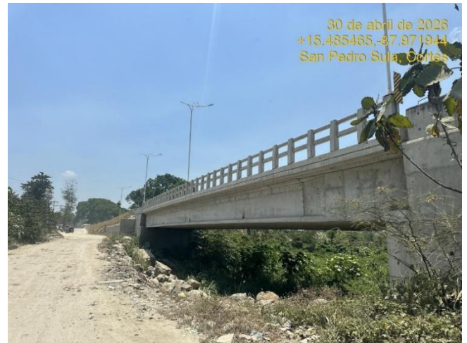
Vigas del puente lado oeste.
