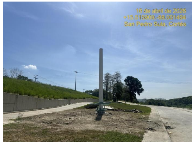
Montaje y fijación de la columna de iluminación.
