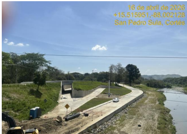
Lado OESTE de la obra.
