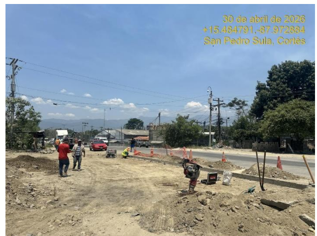
La pavimentación del acceso se va a realizar en 2 partes, debido a la alta presencia de usuarios accediendo a la zona.
