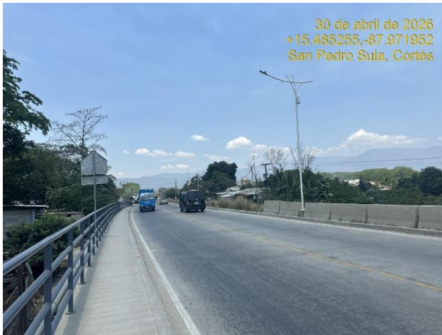
Acera y calzada sobre puente Jucutuma
