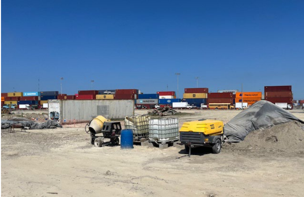
FIGURA 19: OBRAS DE AMPLIACIÓN DE LOS PATIOS 6A, 6B, Y 6C
