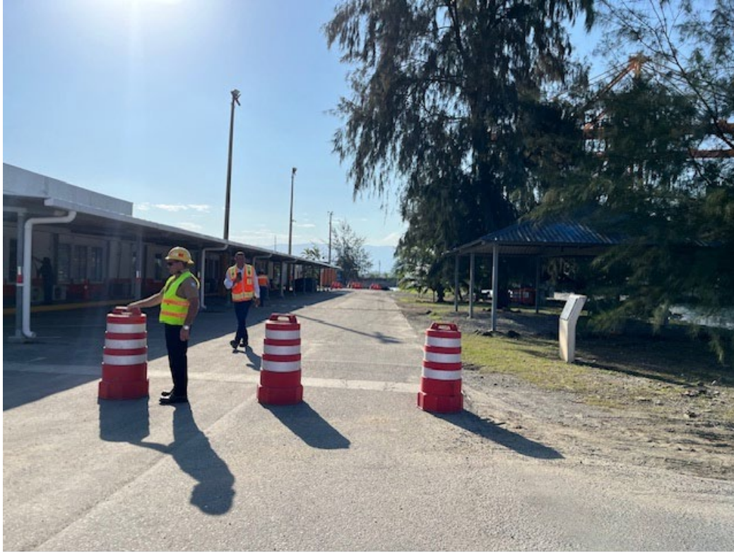
FIGURA 17: NUEVO PATRÓN DE VIALIDAD DEBIDO A OBRAS EN PATIO A
