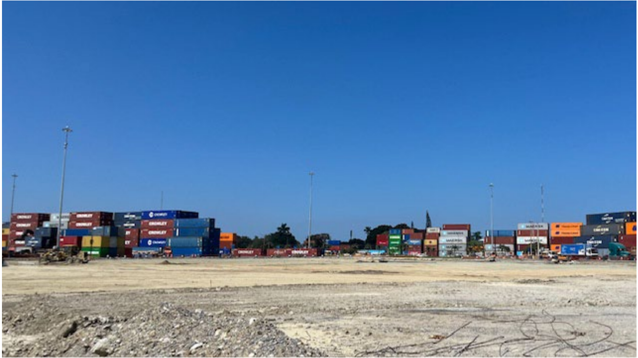
FIGURA 18: OBRAS DE AMPLIACIÓN DE LOS PATIOS 6A, 6B, Y 6C
