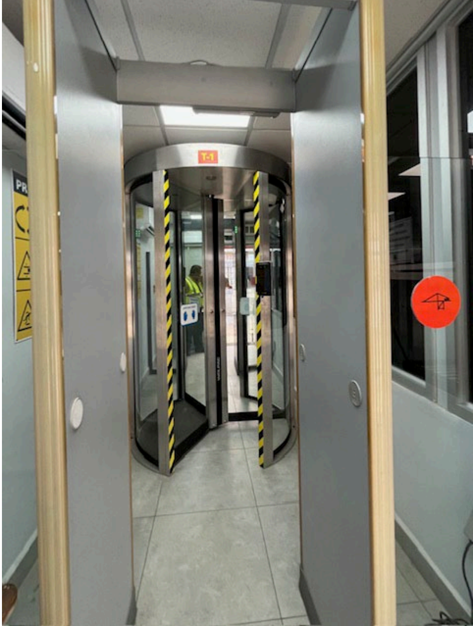
FIGURA 1: NUEVAS INSTALACIONES DE ACCESO PEATONAL
