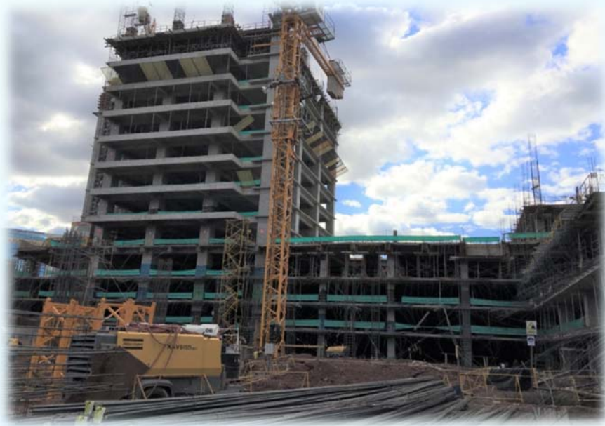
Vista parcial de actividades en Torre 02.
