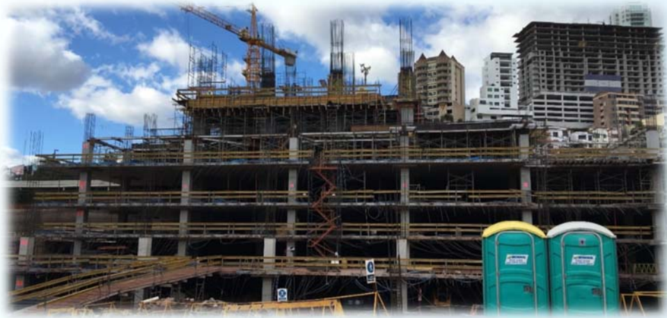
Vista parcial de actividades en Torre 01.
