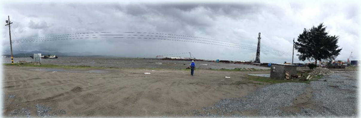
(4) Vista panorámica del futuro muelle No. 6.
