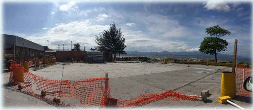
(3) Vista panorámica del área de revisiones C7.
