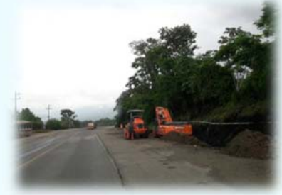
Un pequeño frente de trabajo en el km 19
