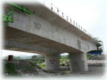
Nótese los carros de avance de la fundición en el extremo del puente
