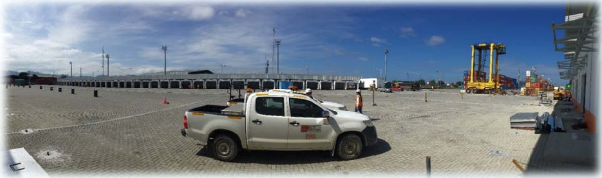
(2) Vista panorámica de las obras en patio de revisiones C7.
