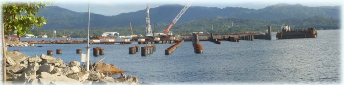
(1) Vista panorámica de las obras en patio de revisiones C7.
