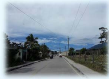
Vista hacia adelante del tramo, todos sus elementos lucen en buen estado
