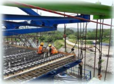
Vista del armado del acero de refuerzo en la superestructura, pila No 2
