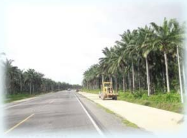
Equipo de construcción en terracerías del km 47
