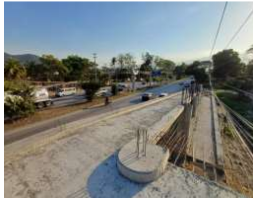
Vista de rampa#2, Oeste.
