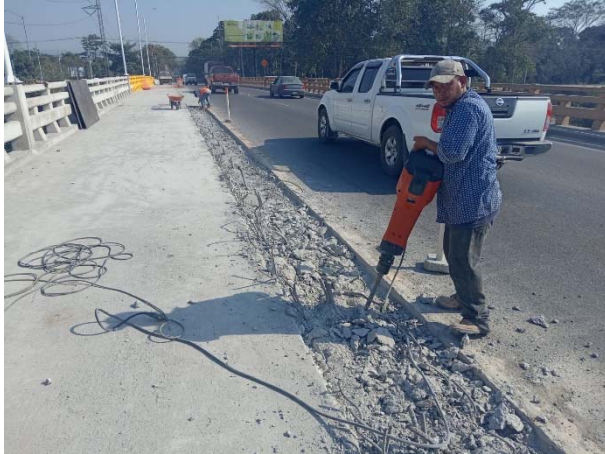
Hombre trabajando en demolición de losa existente, donde estaba ubicado el pretil.
