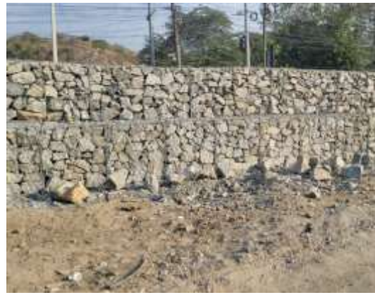
Vista de muro de gaviones entre Est. 0+365 y 0+375.
