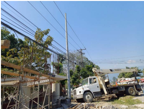
Instalación de postes para cableado eléctrico.
