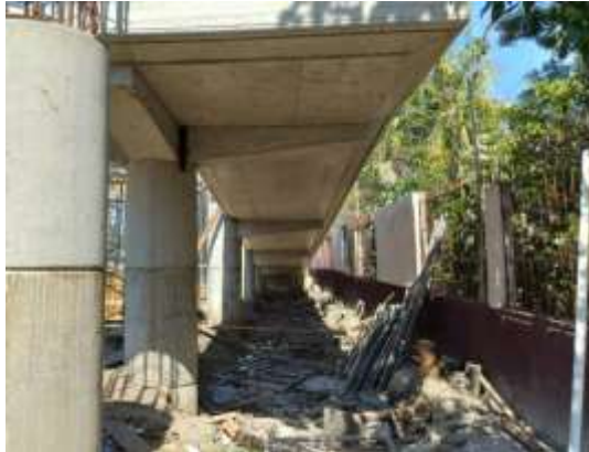
Vista de rampa#1, Este, desencofrada.
