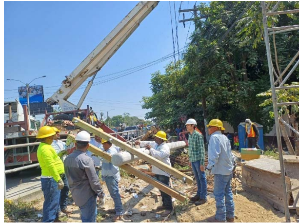
Hombres trabajando en la instalación de postes para cableado eléctrico.
