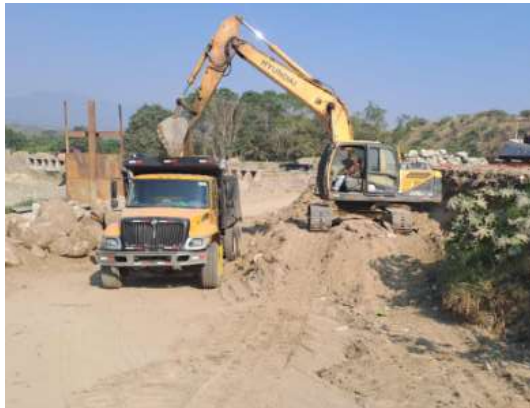
Excavación para muro de gaviones entre Est. 0+025 y 0+050.
