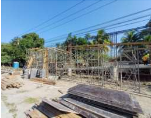
Instalación de andamios para rampa#2, Este.
