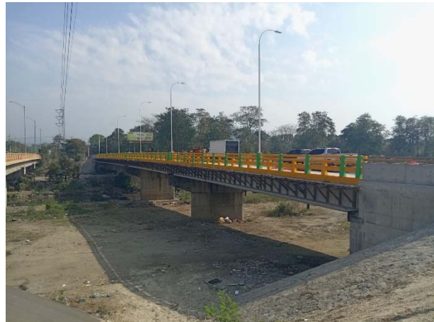
Puente sobre río Bermejo.
