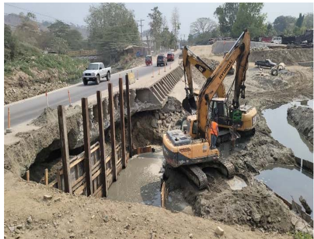
Maquinaria trabajando en dragado.
