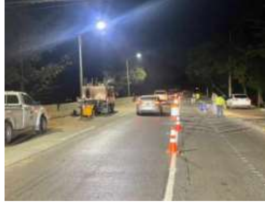
Pintado de señalización horizontal.
