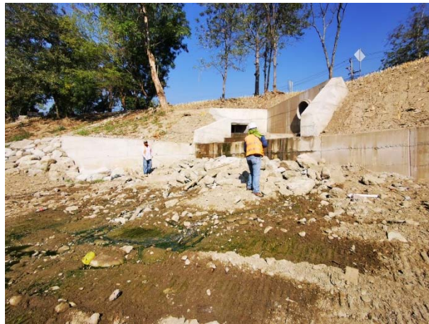
Hombres trabajando en escolleras.
