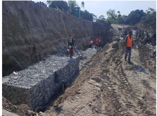
Hombres trabajando en el muro de Gaviones.
