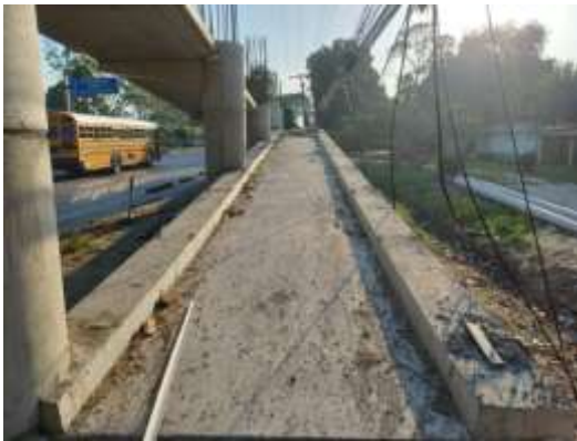
Vista de rampa#1, Oeste.
