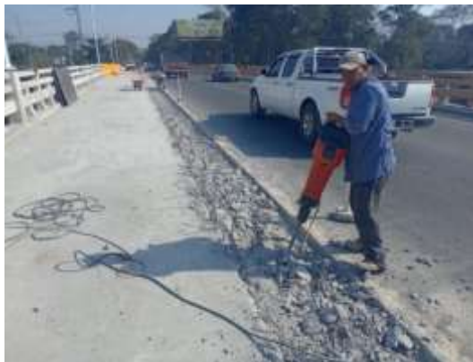
Demolición para encajonado entre losas en claro No. 1 y 2.
