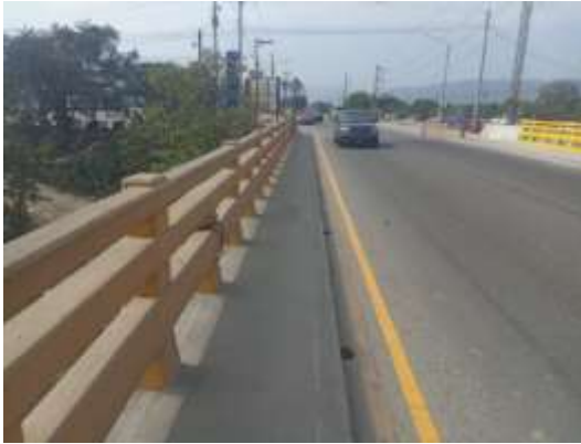
Pintado de señalización horizontal.
