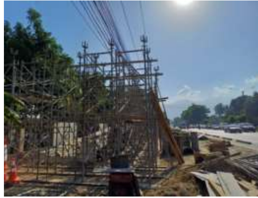
Instalación de andamios para descanso#2, Este.
