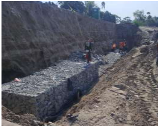
Construcción de gaviones entre Est. 0+025 y 0+050.
