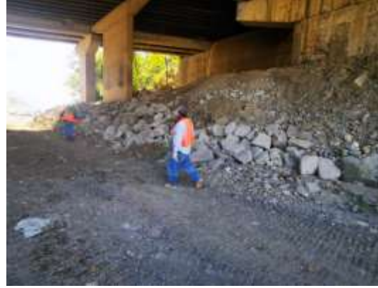
Escollera para protección a pilastras.
