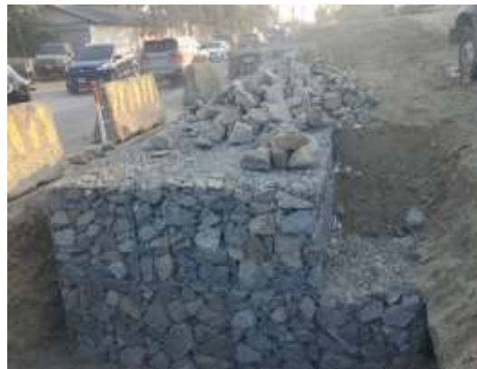
Construcción de gaviones entre estaciones Est. 0+365 y 0+375.
