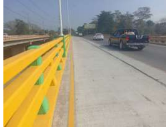
Pintado de señalización horizontal.
