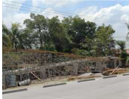
Vista de andamios instalados para rampa#2, Este.
