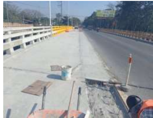
Colado de concreto en encajonado entre losas de claro No. 3 y 4.
