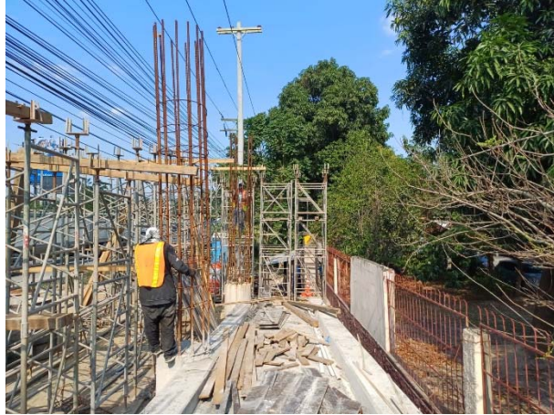
Hombres trabajando en el encofrado de Rampa Oeste.
