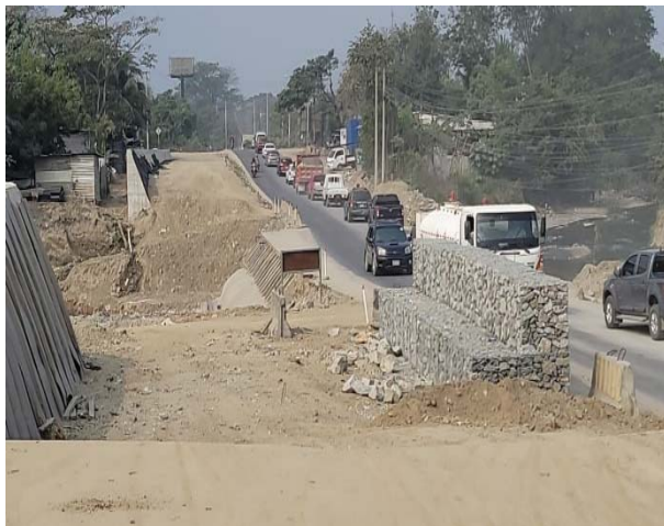
Muro de Gaviones.
