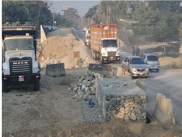
Muro de Gaviones.
