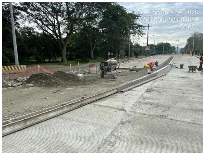
Fundición de bordillo en tramo de Acceso Al Carmen.
