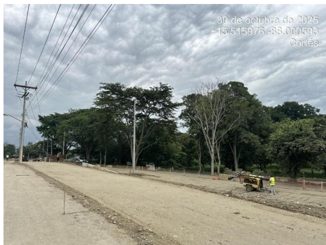
Habilitado camino alterno de doble vía
