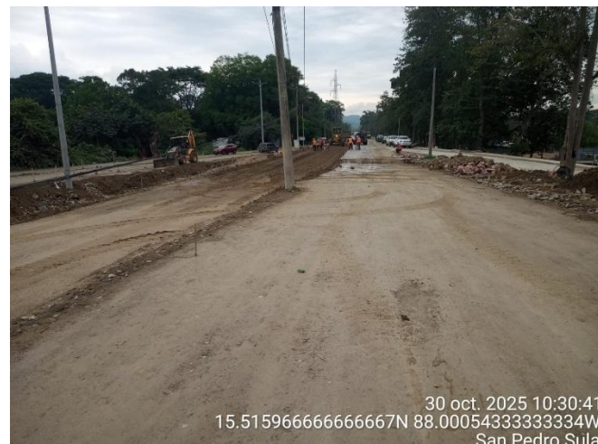
Instalación de postes para sistema de iluminación.
