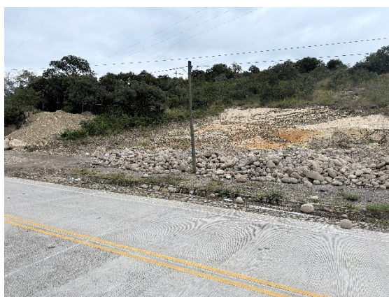
Se observa el plantel con doble tratamiento de la zona de la falla km 77 en el cual se colocó piedra la cual parece será para realizar muro de gaviones
