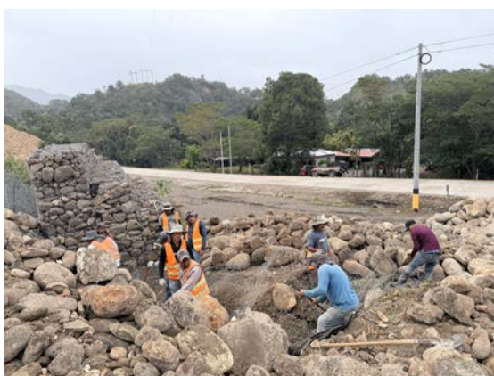
Muro de gaviones afectado por movimiento en zona de la falla km 77 el cual se encuentra siendo desarmado algunas de las secciones que se encuentran afectadas por los movimientos.
