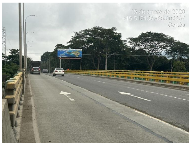
Puente este, sobre rio Bermejo, segundo anillo.
