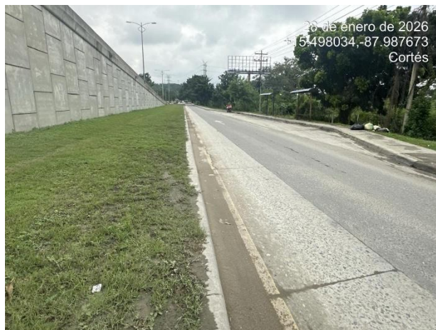
Carril de aproximación en parte norte.
