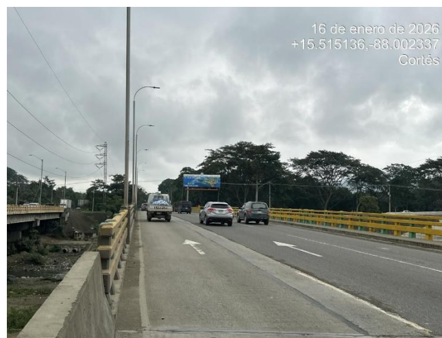
Ampliación del tercer carril sobre puente.
