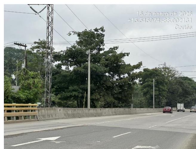
Barreras Newjersey en obra No.21
