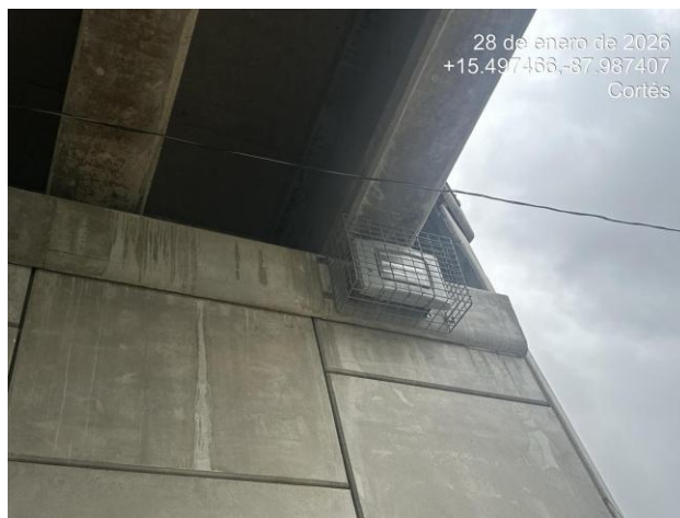
Lamparás bajo el puente en buen estado.
