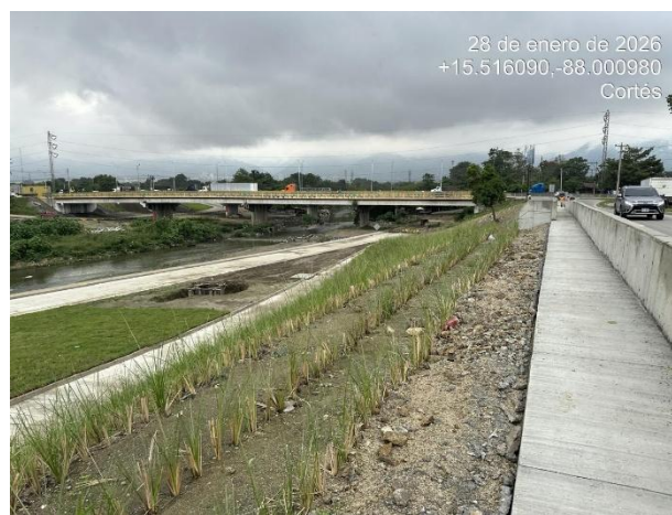
Vetiver en talud rampa 4.
