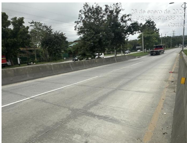
Señalización horizontal visibles en carril sobre el puente.
