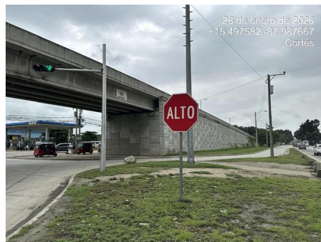
Señalización vertical en parte sur.
