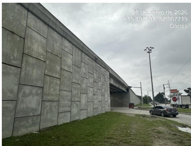
Parte sur del puente a desnivel.
