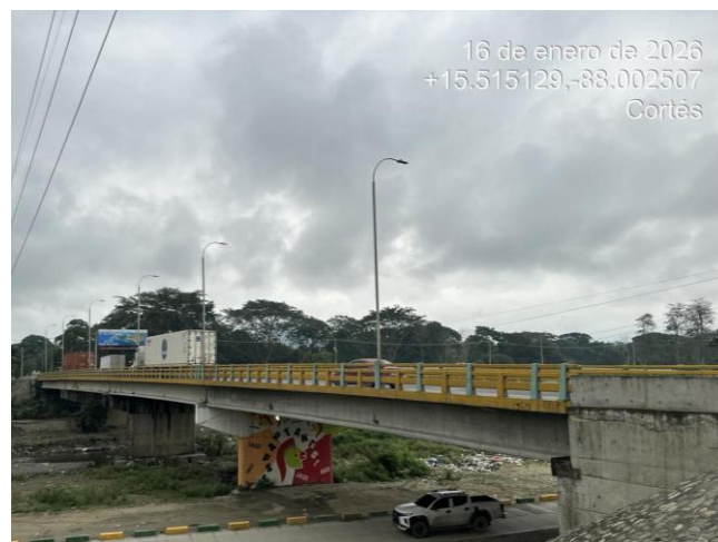
Puente este, segundo anillo sobre rio Bermejo.
