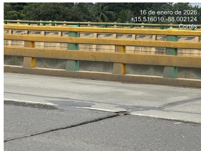
Subsanación en la Junta longitudinal enero 2026.
