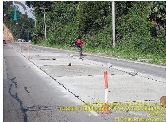
Vista de las losas recién fundidas y con sello elastómero en sus juntas, balizas no permiten paso de vehículos mientras gana resistencia el concreto.
