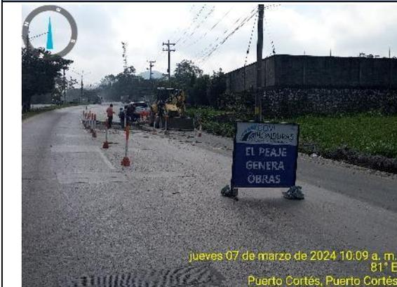
Se observa la señalización vertical en los trabajos de demolición de losas fracturadas y con baches en estación 41+040.
