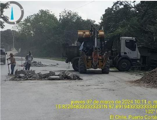
Removiendo las losas fracturadas con retro y volqueta.
