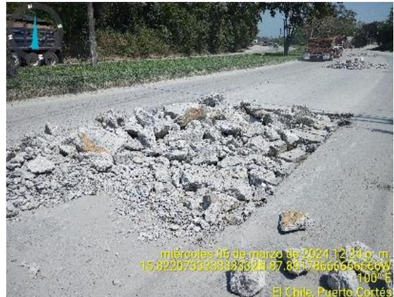
Vista de fragmentos de losa en calzada con baches, listos para ser removidos en estación 40+340.
