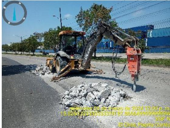
Vista de retro con roto-martillo demoliendo losa en calzada con baches en estación 37+600.
