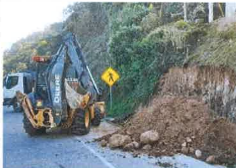
Foto 4. Estación 140 - 146 lado derecho Taulabé – Desvió a Santa Cruz de Yojoa Remoción de material derrumbado sobre estructura de drenaje.
