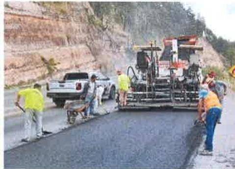
Foto 4. Comayagua - Siguatepeque Colocación de mezcla asfáltica en caliente.
