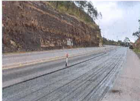
Foto 2. Comayagua - Siguatepeque Fresado de carpeta asfáltica dañada, capa superior 5 cm.
