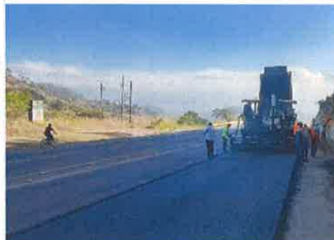
Foto 5. Comayagua - Siguatepeque Vista de la mezcla asfáltica colocada en caliente
