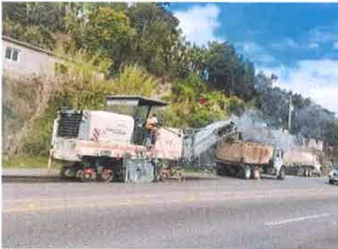
Foto 1. Comayagua - Siguatepeque Fresado de carpeta asfáltica dañada, capa superior 5 cm.
