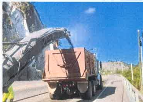
Foto 2. Estación 91 – 92.980 lado derecho Comayagua - Siguatepeque Fresado de carpeta asfáltica dañada, capa superior 5 cm.
