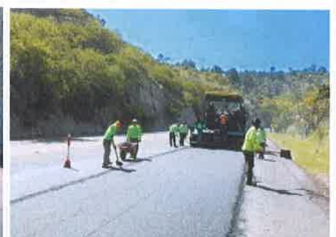
Foto 6. Comayagua - Siguatepeque Colocación de mezcla asfáltica, e: 5 cm.
