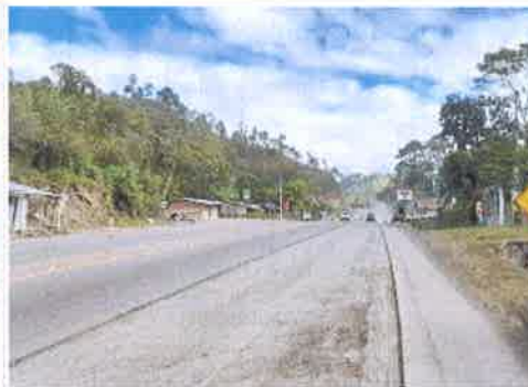
Foto 2. Comayagua - Siguatepeque Fresado de carpeta asfáltica dañada, capa superior 5 cm.
