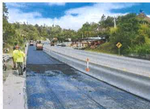
Foto 5. Comayagua - Siguatepeque Compactación de mezcla asfáltica colocada en caliente
