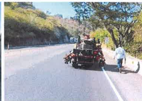
Foto 6. Comayagua - Siguatepeque Aplicación de pintura blanca, línea exterior de la calzada.
