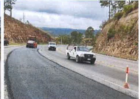
Foto 3. Comayagua - Siguatepeque Compactación de mezcla asfáltica colocada en caliente
