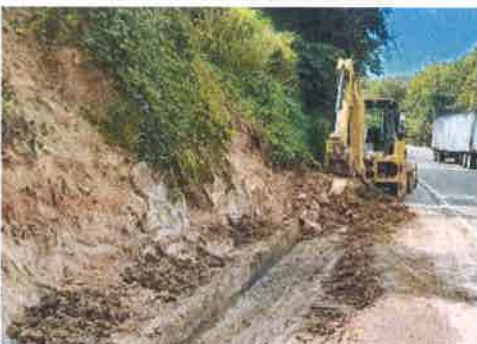
Foto 4. Estación 132 lado derecho Siguatepeque – Taulabé Remoción de material derrumbado sobre estructura de drenaje.
