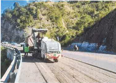
Foto 1. Comayagua - Siguatepeque Fresado de carpeta asfáltica dañada, capa superior 5 cm.
