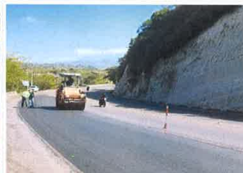
Foto 5. Comayagua - Siguatepeque Compactación de mezcla asfáltica colocada en caliente
