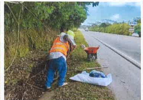
Foto 6. Estación 164 lado derecho Taulabé – Desvió a Santa Cruz de Yojoa Retiro de material azolvado en cuneta enchapada
