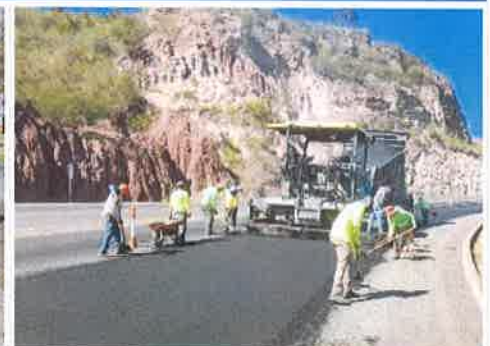
Foto 3. Comayagua - Siguatepeque Colocación de mezcla asfáltica, e: 5 cm.
