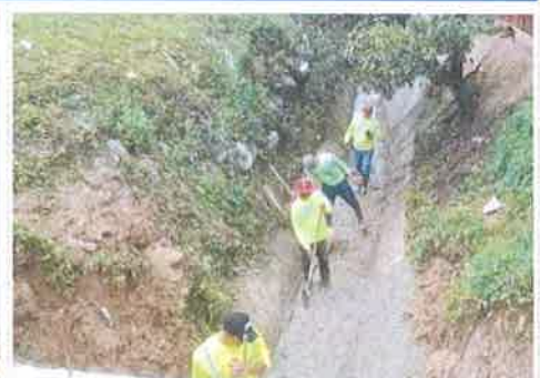
Foto 3. Estación 150+700 lado derecho Taulabé – Desvió a Santa Cruz de Yojoa Fundición de losa inferior en canal de salida, tubería TCR de 48"
