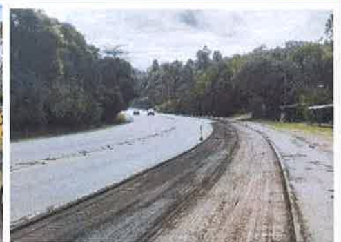
Foto 3. Comayagua - Siguatepeque Fresado de carpeta asfáltica dañada, capa superior 5 cm.
