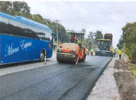
Foto 4. Comayagua - Siguatepeque Compactación de mezcla asfáltica colocada en caliente
