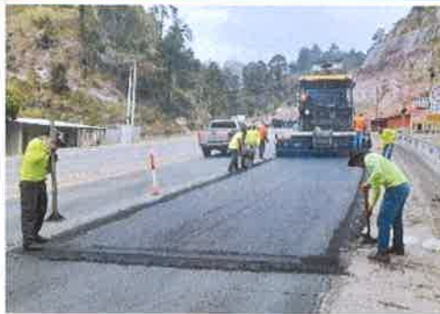
Foto 2. Comayagua - Siguatepeque Colocación de mezcla asfáltica, e: 5 cm.
