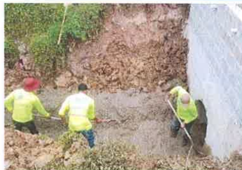
Foto 2. Estación 150+700 lado derecho Taulabé – Desvió a Santa Cruz de Yojoa Fundición de losa inferior en canal de salida, tubería TCR de 48"
