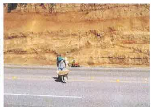
Foto 6. Estación 165 lado derecho Taulabé – Desvío a Santa Cruz de Yojoa Retiro de material azolvado en cuneta enchapada
