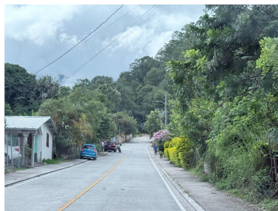
Se observa el final de la supervisión en tramo Gracias – Celaque
