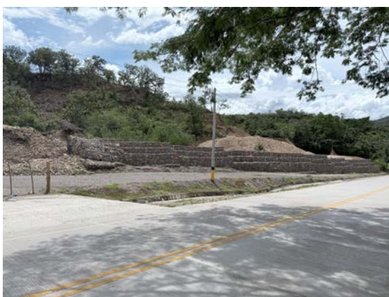
Muro de gaviones afectado por movimiento en zona de la falla km 77
