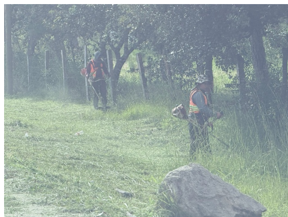
Se observa personal de el contratista realizando chapeo
