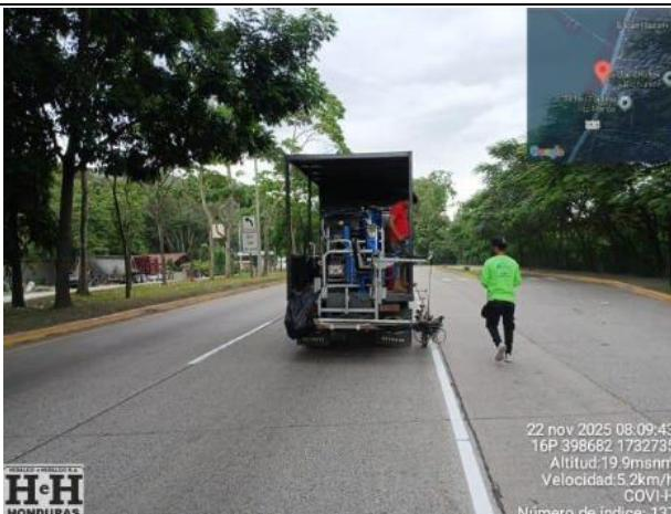
Vista de los trabajos de pintura termoplástica en calzada de concreto hidráulico.
