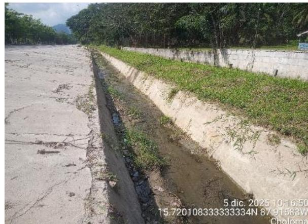
Vista de los trabajos de limpieza de cunetas enchapadas con concreto hidráulico, siendo parte del mantenimiento rutinario.
