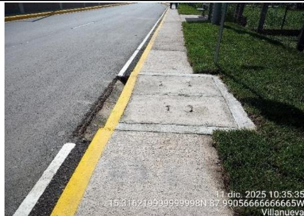
Vista de aceras con tapaderas de los tragantes verticales y se aprecia pintura termoplástica en calzada de Proyecto Intercambiador de Villanueva – San Manuel.
