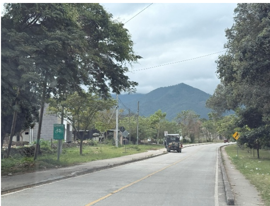
Se observa calzada completamente limpia y señalización en buen estado
