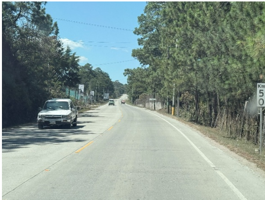
Se observa calzada, bordillos y señalización cumpliendo estándares de servicio
