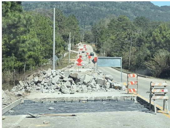
Se observa en el tramo San Juan – Gracias supervisión del ranurado en las pastillas restauradas debido a los agrietamientos
