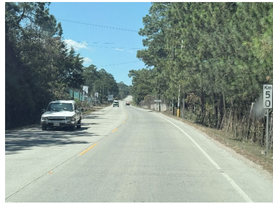
Se observa que el tramo se encuentra en buenas condiciones y siendo seguro para el tránsito
