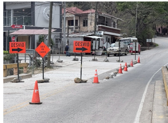
Se observa en el tramo San Juan – Gracias las medidas de mitigación de riesgos a los usuarios debido a restauraciones debido a los
