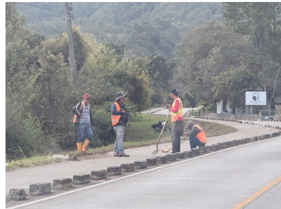
Se observa personal del contratista realizando limpieza de la calzada
