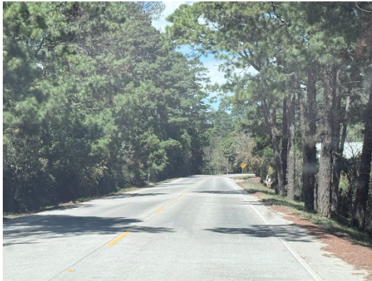
Se observa el tramo completamente transitable limpio y señalizado
