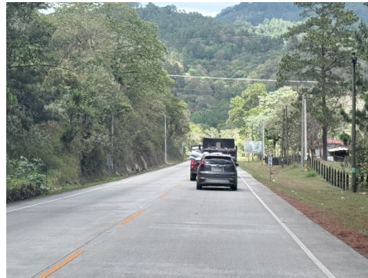
Se observa el inicio de la supervisión en tramo Gracias – Celaque
