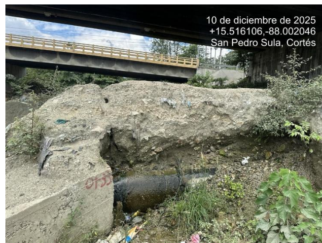
Tubería de 24" HFD en la cual se harán trabajos para reubicarla.
