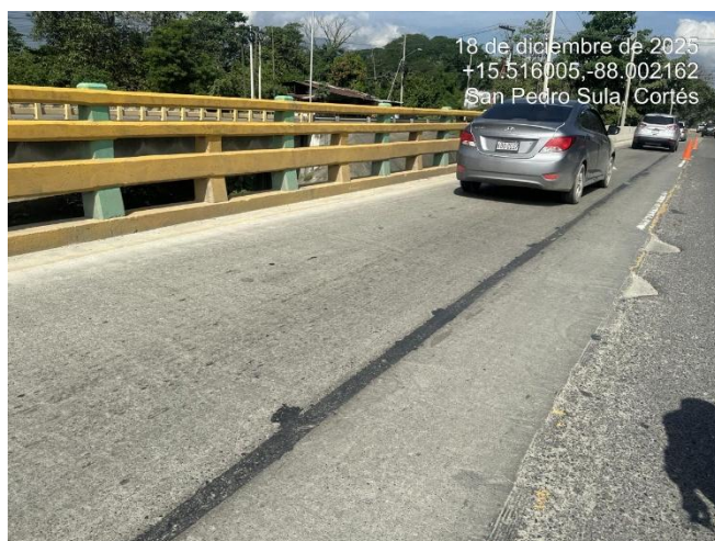
Tramo de junta longitudinal intervenido, donde se aplicó material para sellarla.
