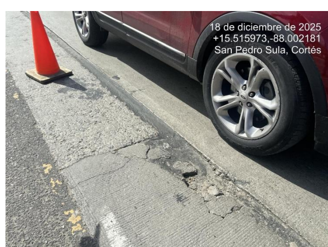
Falla presente en junta longitudinal
