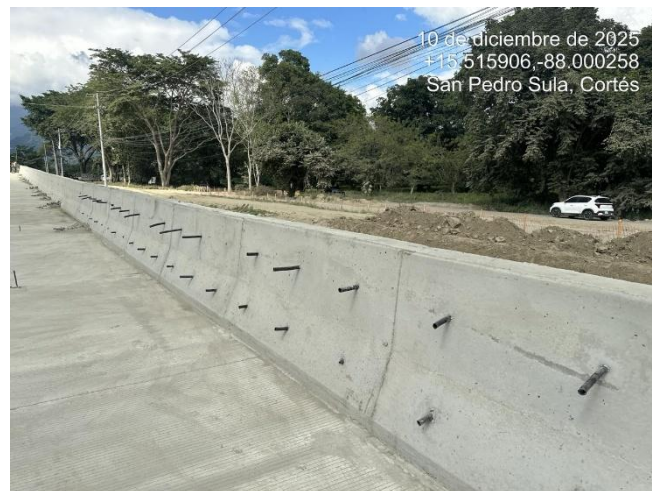
Colado de concreto de tramo de barrera New Jersey entre Est. 0+125 – 0+145.
