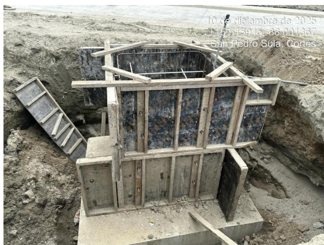
Encofrado de base para luminarias en área verde.
