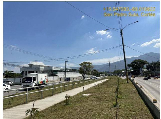
Áreas verdes y barandal para uso de peatones en retorno norte.
