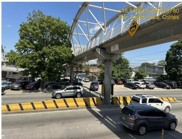
Barrera Jersey bajo puente con pintura visible.
