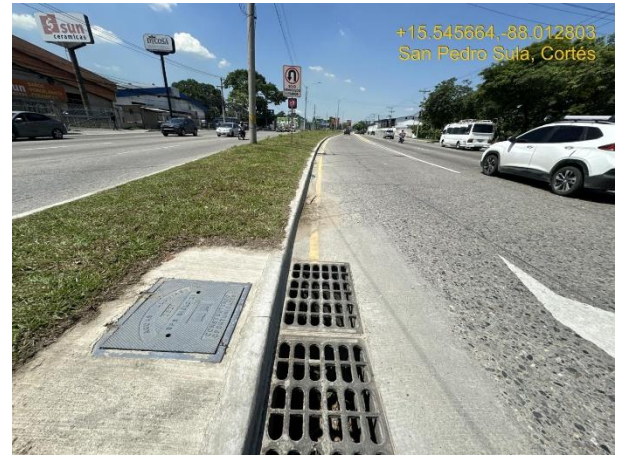
Tragantes ubicados en acceso a retorno norte.
