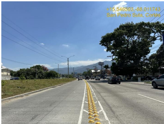
Boyas ubicadas en salida de Retorno norte. Trocha Norte-Sur.
