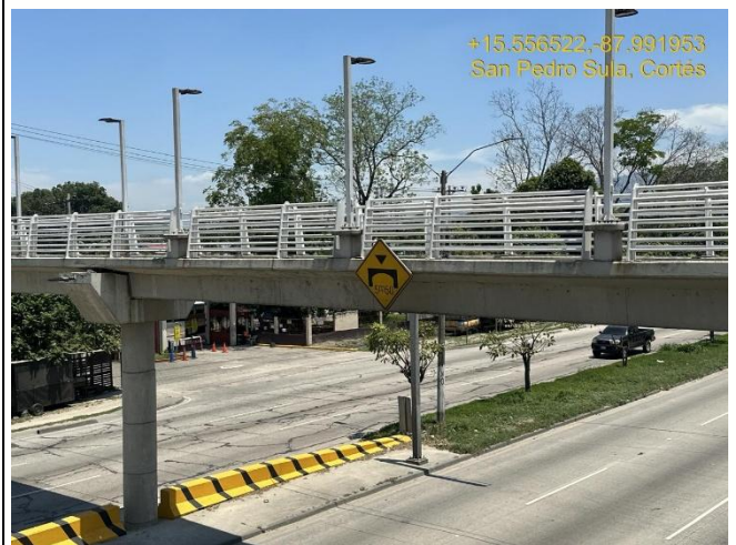
Se verificó el estado de la pintura en barandal y el estado de la señalización vertical.
