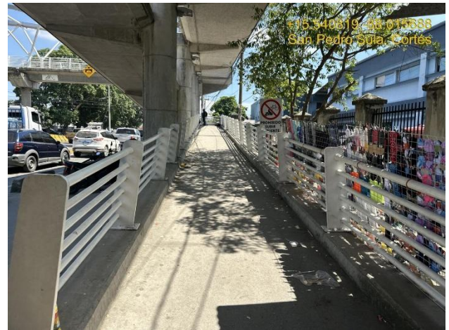
Rampa de acceso, lado oeste.
