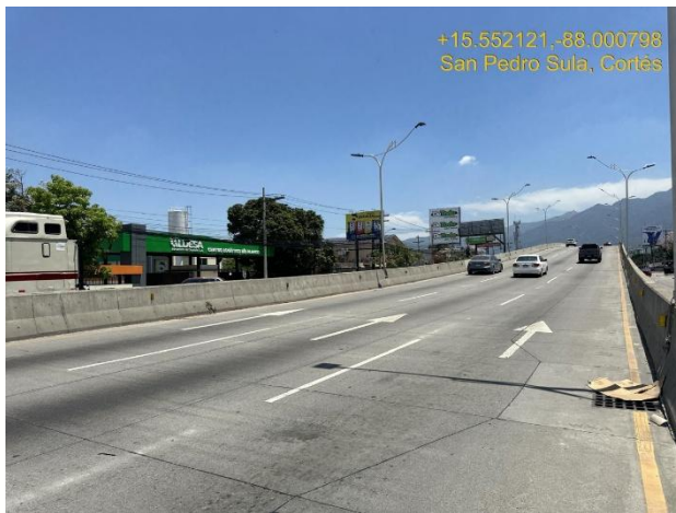
Sobre puente a desnivel extremo norte.
