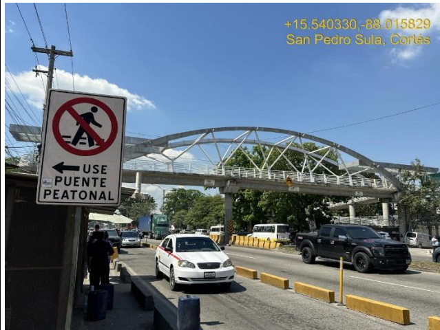
Señalización vertical lado sur oeste del puente peatonal.
