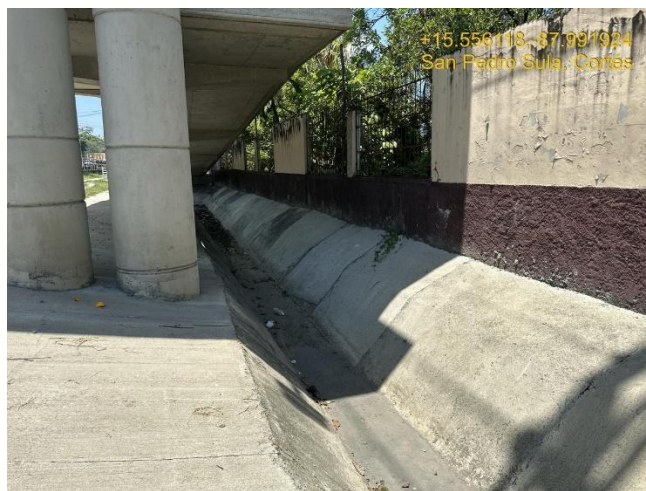
Canal revestido lado este de la obra.
