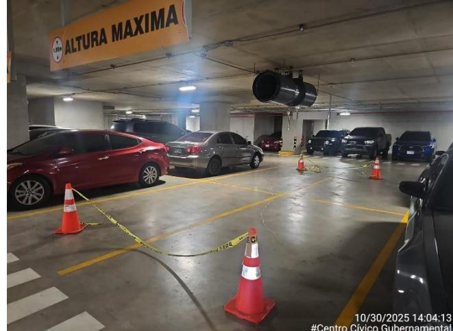
Inhabilitación de cuatro plazas vehiculares por cada Jet Fan instalado, en todos los niveles de estacionamiento, lo que reduce la capacidad de estacionamientos en el Centro Cívico.
