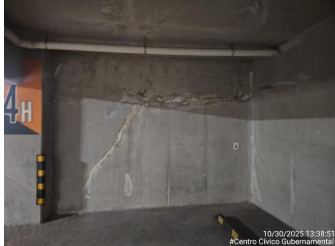
El muro de concreto armado presenta grieta en diagonal en ambas caras, lo que podría suponer un asentamiento o posible una falla estructural
