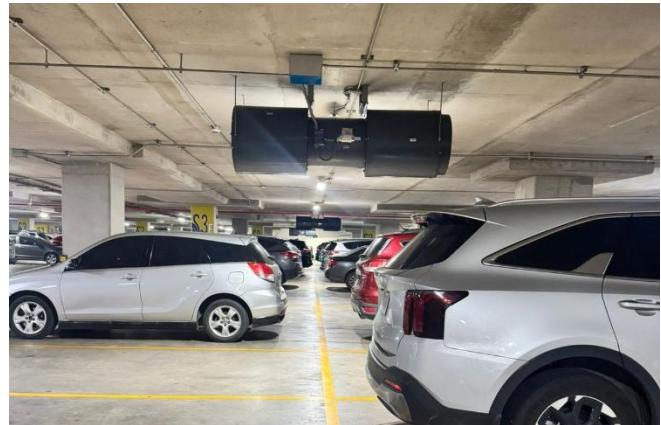
Se constato que algunas lámparas del sistema de iluminación no se encuentran en funcionamiento, mientras que otras presentan funcionamiento intermitente, lo que ocasiona una iluminación deficiente en determinados sectores del sótano S3. Asimismo, se constato que el equipo Jet Fan está instalado a una altura variable de 2.03 – 2.06 m distinto a la recomendación del fabricante.
