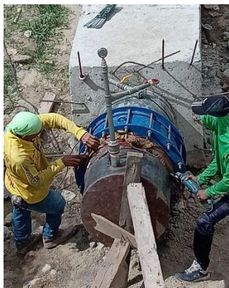
ING CONSTRUCCIONES realiza instalación de junta dresser.
