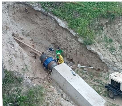
ING CONSTRUCCIONES realiza instalación de junta dresser.
