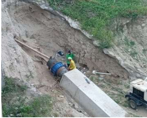
ING CONSTRUCCIONES realiza instalación de junta dresser.
