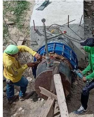
ING CONSTRUCCIONES realiza instalación de junta dresser.
