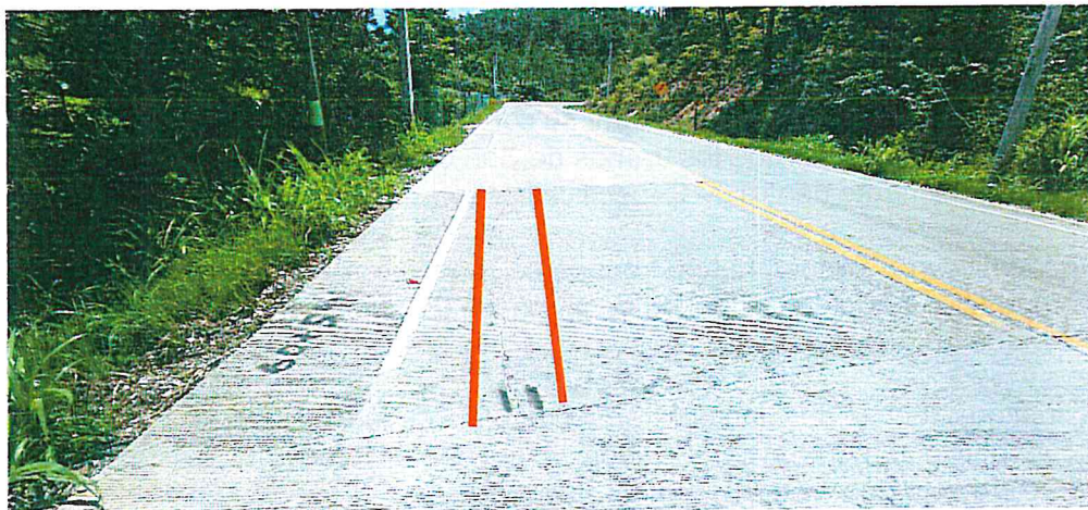
Sellar Grieta en el Km 69+243 L. I.
