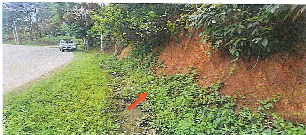
Cuneta Enchapada azolvada en el Km 54+464 – 54+605 L. D.
