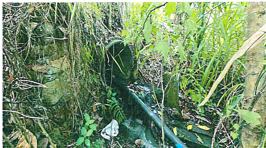
Toma de la Alcantarilla Transversal del Km 61+737 donde se puede observar su salida completamente limpia.
