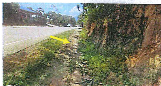
Cuneta Enchapada azolvada en el Km 54+220 – 54+350 L. I.
