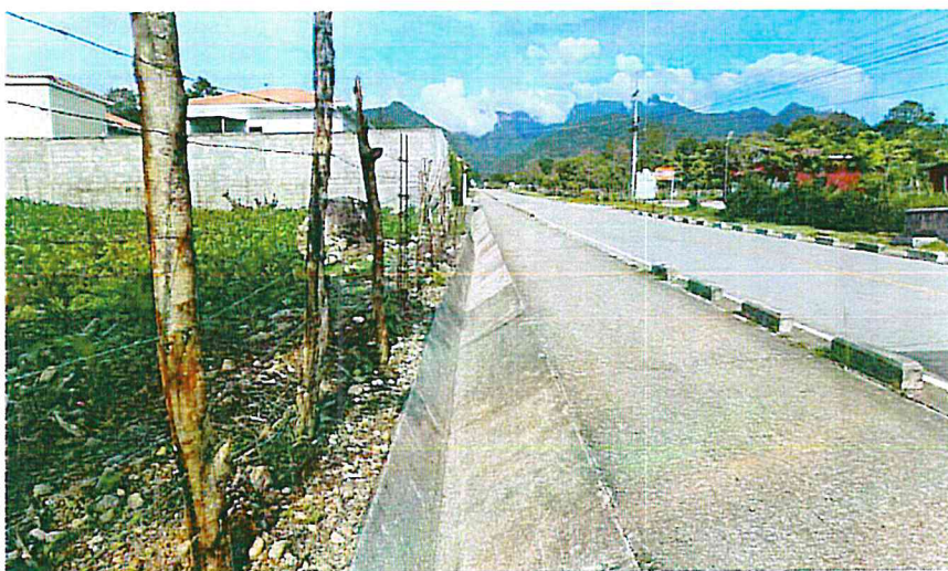
Toma de la Cuneta Enchapada del Km 3+138 L. I. Se puede observar que se mantiene totalmente limpia y libre de sedimentos.
