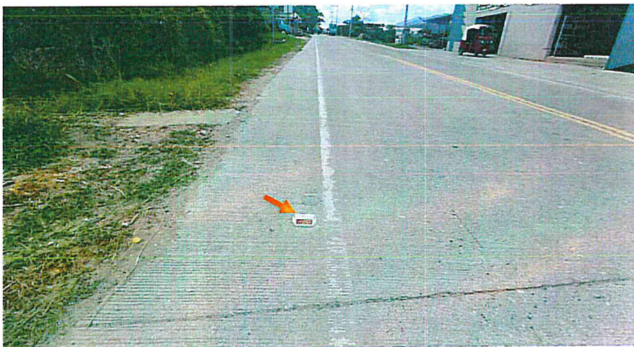
Toma de la pintura Termoplástica en el Hombro Izquierdo y Viales del km 48+267 donde se puede observar que aun están en buen estado y se mantienen colocadas.
