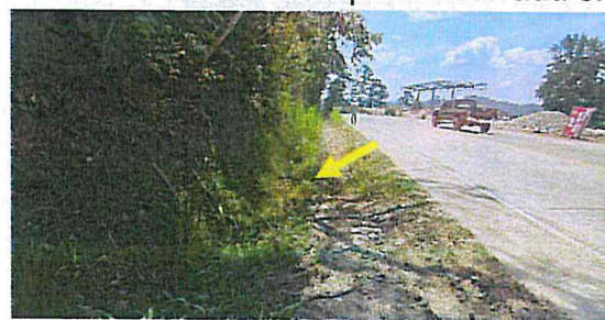
Cuneta Enchapada azolvada en el Km 54+930 – 55+100 L. I.
