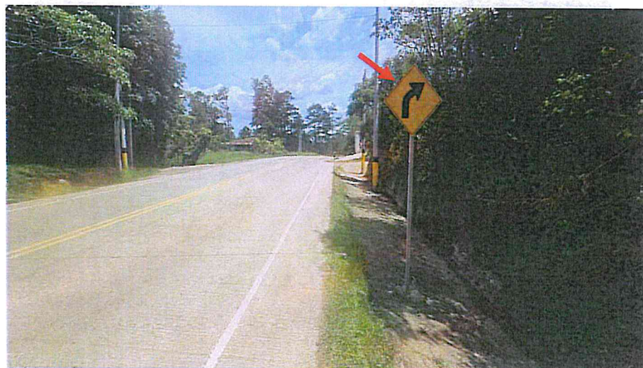
Toma de la Señal Vertical del km 53+632 L. I. donde se puede observar que se mantiene en buen estado.
