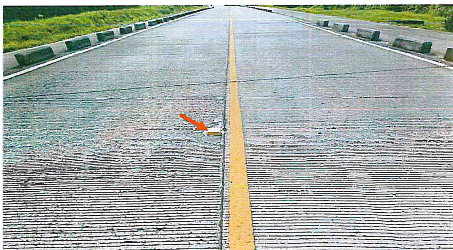
Toma en la Línea Central del Km 5+146, donde se puede constatar que tanto la Pintura Termoplastica como las Vialitas de ese tramo se mantienen buen estado.
