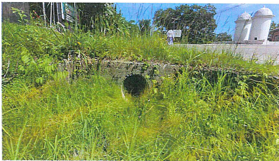
Toma en el Acceso Lateral del km 82+492 L. I., se puede observar que tanto su salida y su interior están limpios.
