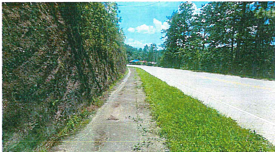
Toma de la Cuneta Enchapada del Km 56+732 L. I., se puede ver que se encuentra totalmente limpia, sin basura y sin sedimentos.
