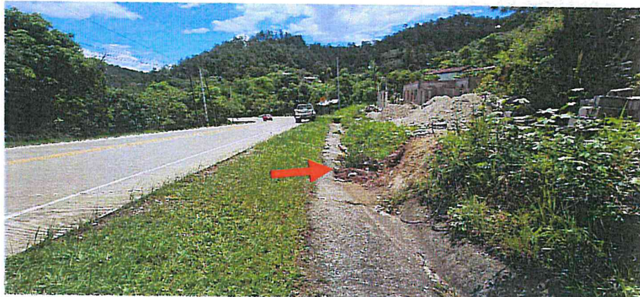
Cuneta Enchapada azolvada en el Km 61+740 – 61+860 L. D.
