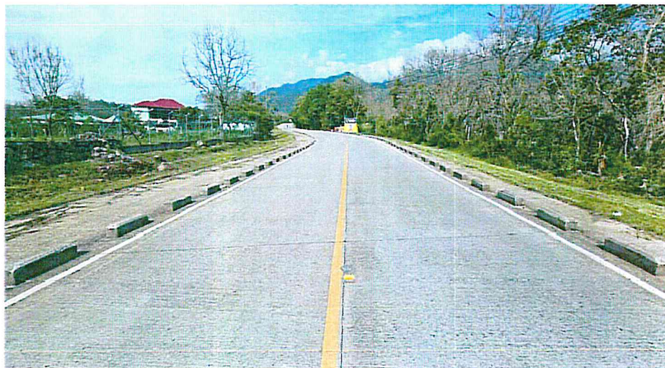
Imagen de la Pintura Termoplastica del Km 2+358 donde se puede observar que la de la línea central aun se mantiene en buen estado.
