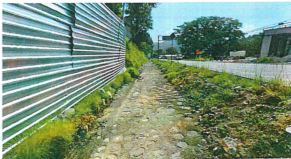
Toma de la Cuneta Enchapada en el Km 83+022 L. D., donde se puede observar que esta totalmente limpia y sin material azolvado.
