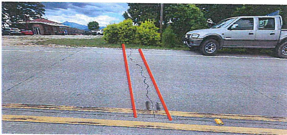
Sellar Grieta en el Km 82+487 L. D.
