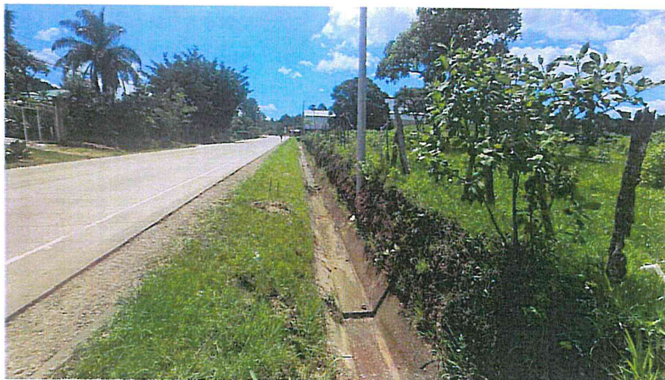
Imagen en el Derecho de Vía en el Km 49+975L. D.
