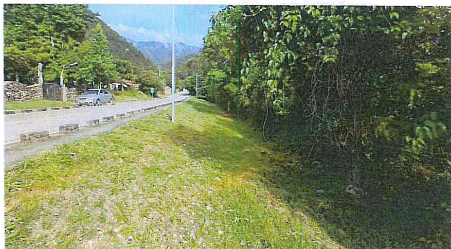
Toma en el Derecho de Vía en el Km 5+249 L. D., observese que está completamente limpio y la maleza a niveles de Especificaciones
