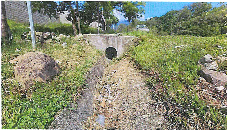
Toma del Acceso Lateral del Km 1+343 L. I. Obsérvese que tanto su
