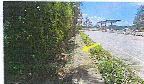
Cuneta Enchapada azolvada en el Km 54+930 – 55+100 L. I.
