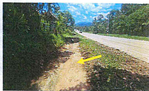
Cuneta Enchapada azolvada en el Km 53+707 – 53+817 L. I.
