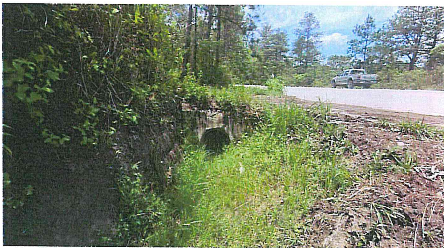
Imagen en el Acceso Lateral en el Km 63+534 L. D. donde se puede observar la tubería que esta limpia tanto en su salida como su interior.
