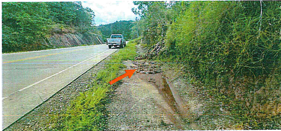
Cuneta Enchapada azolvada en el Km 57+745 – 58+000 L. D.
