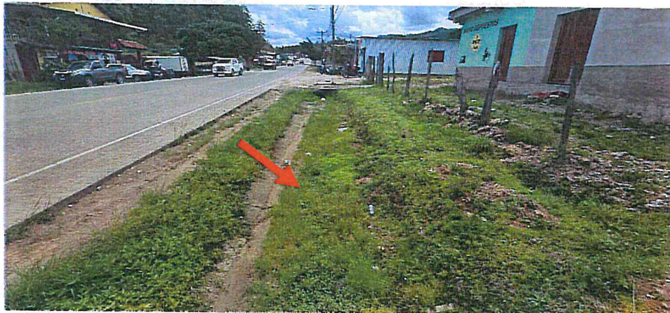
Cuneta Enchapada azolvada en el Km 54+464 – 54+605 L. D.
