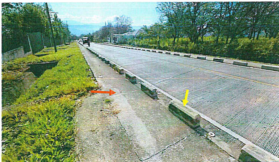
Toma de la Acera (rojo) y Bordillo Intermitente (Amarillo) en el Km 2+979 L. D., observese que ambos se mantienen en buen estado.
