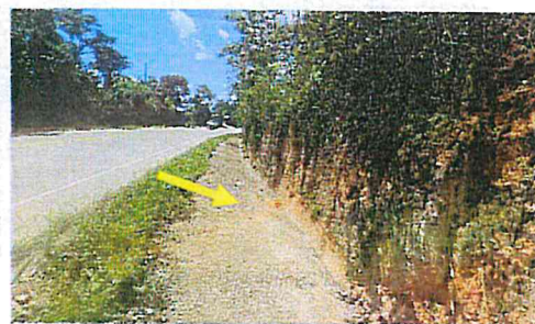
Cuneta Enchapada azolvada en el Km 54+220 – 54+350 L. I.
