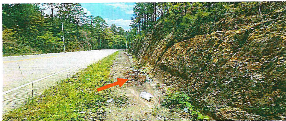
Cuneta Enchapada azolvada en el Km 57+745 – 58+000 L. D.
