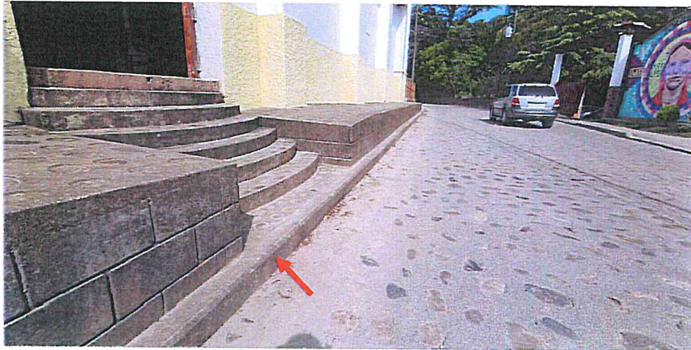
Toma de la Acera y Bordillo Continuo en el Km 0+765 L. I. Se puede observar que se mantienen en buen estado, limpia y completos.
