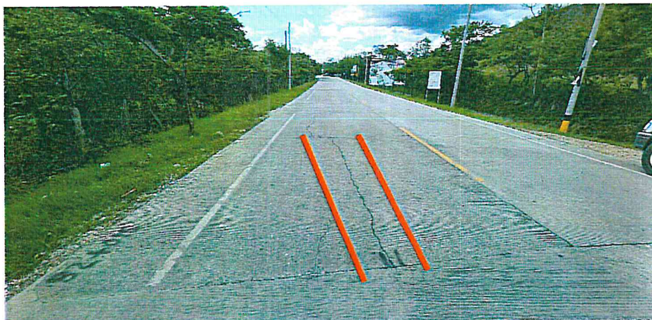
Sellar Grieta en el Km 82+070 – 82+080 L. I.
