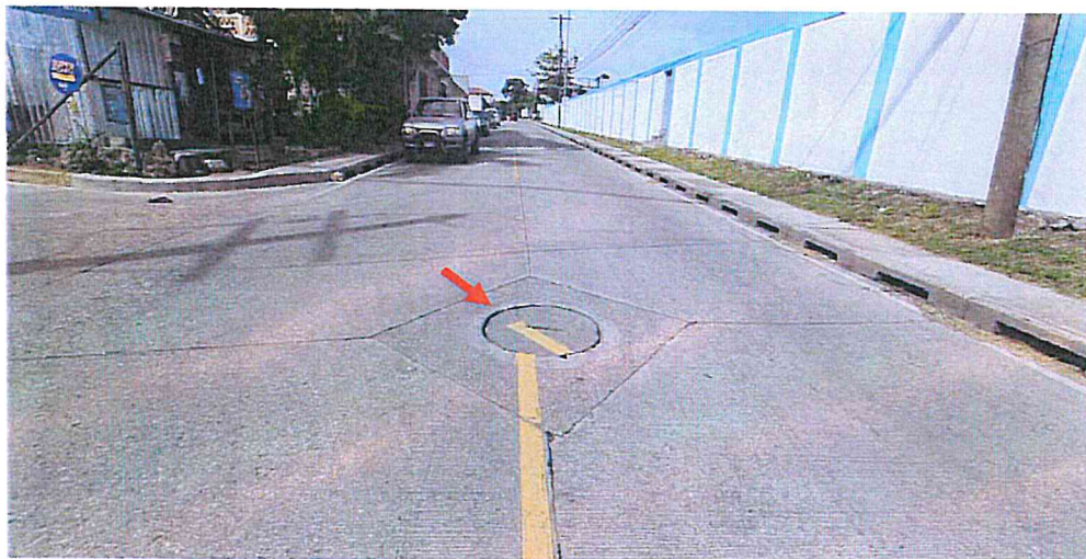
Toma de la Tapadera en el Pozo de Inspección en el Km 0+220. Se puede ver que esta en buen estado.
