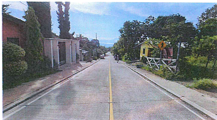
Toma de la Calzada de Rodadura del Km , se puede ver que esta totalmente limpia y sin baches.
