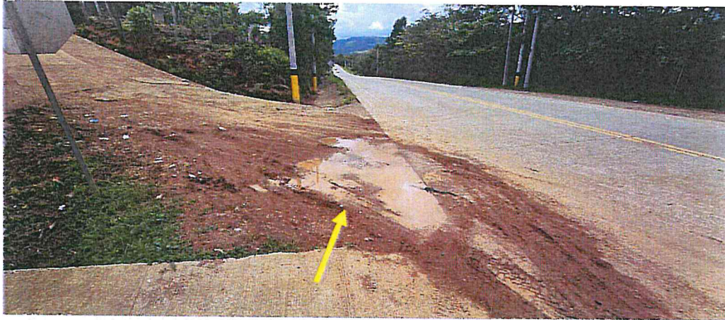
Acceso Lateral rellenado en tramo del Km 53+606 L. I.
