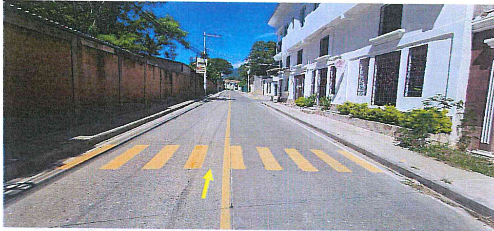
Pintar Paso Cebra en tramo del Km 3+010 – 3+067 A. L.
