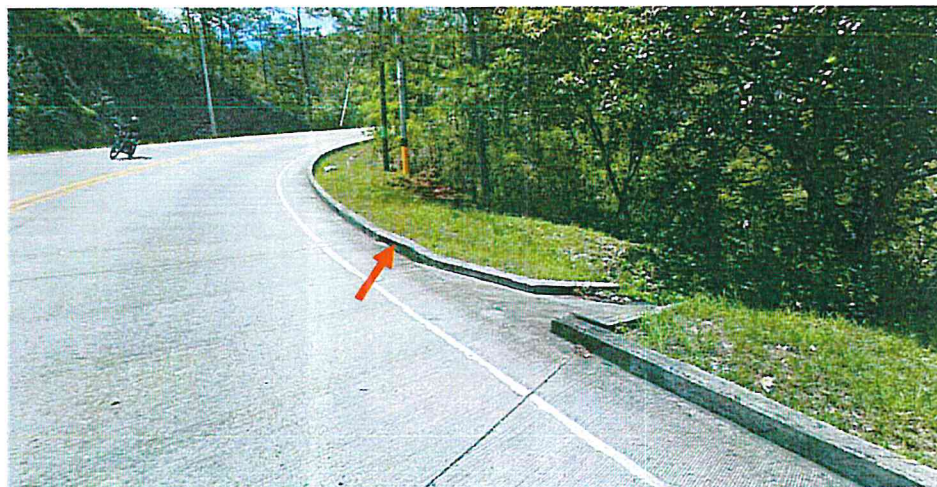
Toma del Bordillo de Carretera en el Km 73+489 L. I., se puede ver que se mantiene en buen estado y libre de materiales en su costado.
