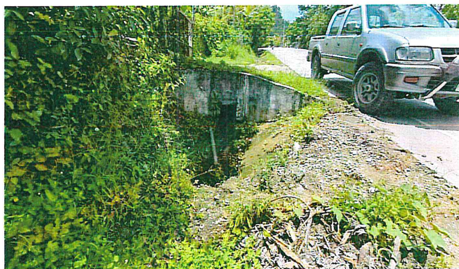
Toma en la salida de la Alcantarilla Transversal del Km 61+737 se puede observar que su canal de entrada en condiciones de drenaje aceptables.
