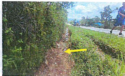
Cuneta Enchapada azolvada en el Km 50+530 – 50+960L. D.
