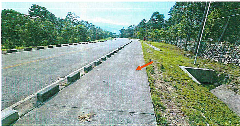
Toma del tramo de Ciclovía en el Km 5+234. Se puede constatar que la Ciclovía se mantienen en buen estado.
