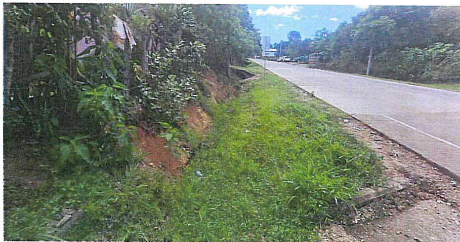
Cuneta sin Enchape del Km 49+848 L. D. Se puede observar que el agua lluvia podría fluir por sobre la cuneta y no se observan erosiones que afecten la carretera.
