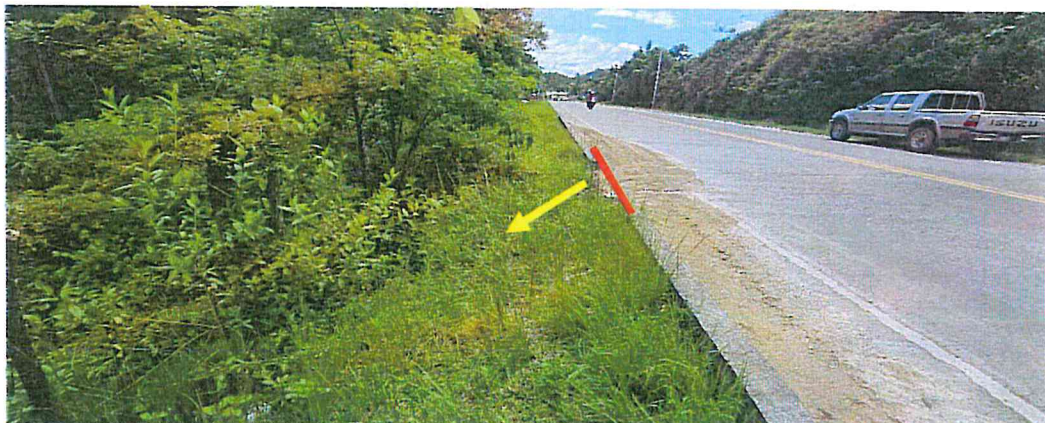
Acceso Lateral rellenado en tramo del Km 58+243 L. I.
