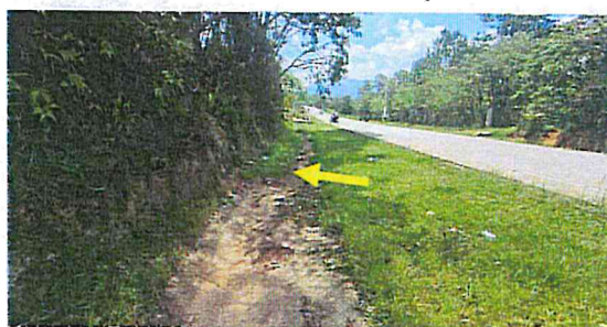
Cuneta Enchapada azolvada en el Km 53+707 – 53+817 L. I.
