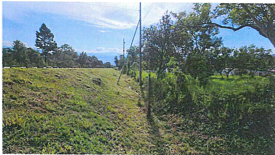
Toma de la Cuneta sin Enchape del Km 3+981 L. I., se puede ver que se mantiene sin erosiones que pongan en riesgo el terraplen.
