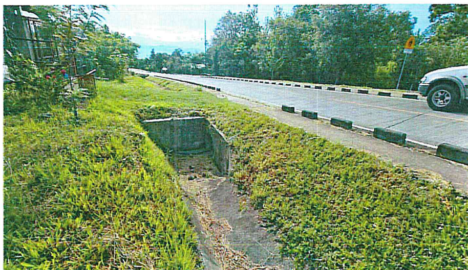
Toma en la entrada de la Alcantarilla Transversal en el Km 4+523. Observe que esta libre de materiales.
