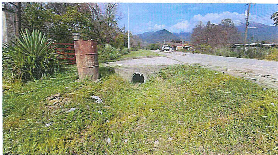
Toma del Acceso Lateral en el Km 2+221 L. I. Se puede ver que tanto su salida como su interior se mantiene limpio.
