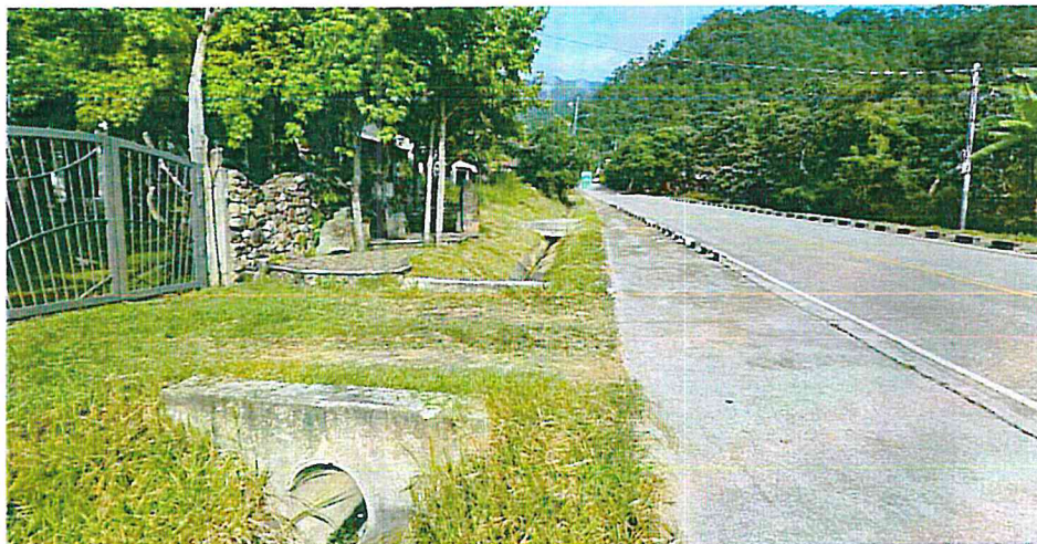
Toma del Acceso Lateral sin Pavimento en el Km 5+279 L. I., se puede ver que aun no se produce la grada entre la Acera y el relleno.
